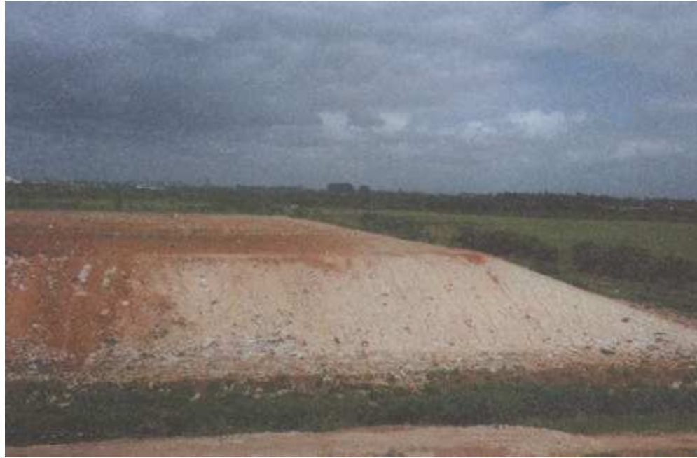
Figura 5 – Célula de aterro tronco-pirâmida executada em área. Adaptado de BIDONE & POVINELLI (1999).
