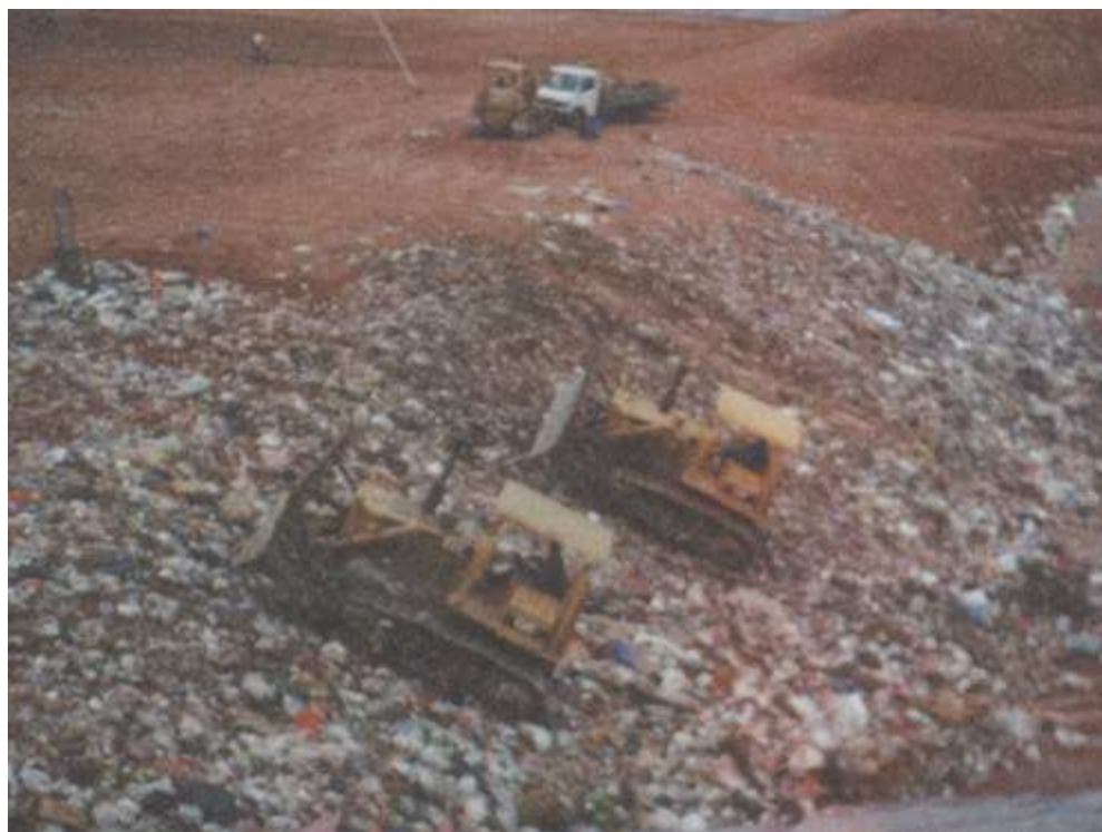
Figura 4 – Compactação dos resíduos contra uma encosta. Adaptado de BIDONE & POVINELLI (1999).
