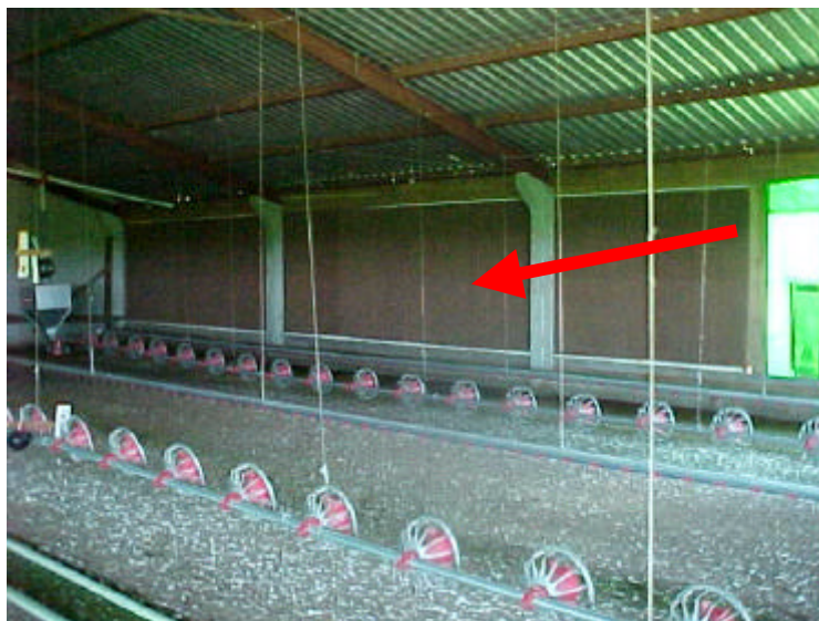
Figura 2.1 - Vista interna do galpão com a disposição do material poroso nas extremidades laterais opostas aos exaustores.
