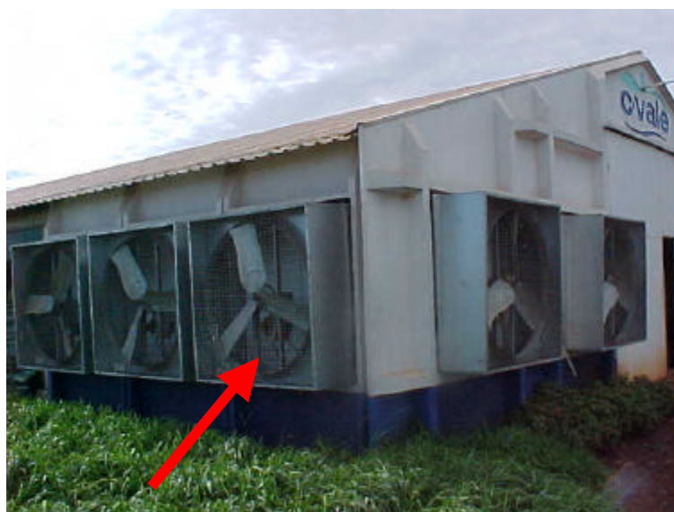
Figura 2.2 – Vista externa do galpão. No detalhe a disposição dos exaustores.
