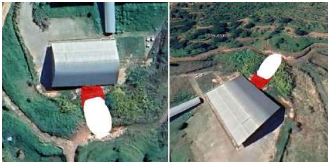
Figura 50 - Resultado da Análise de Alcance do Parque do Cristo (vista de topo e perspectiva): superfície de ruptura em branco e alcance calculado da massa de solo rompida em vermelho. Fonte: Autor
