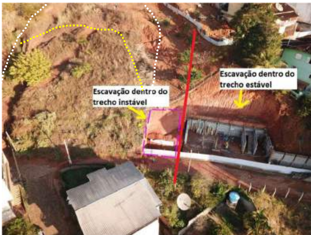
Figura 14 - Vista superior da área com divisão entre o trecho estável e instável e marcação das trincas. Fonte: Defesa Civil de Ponte Nova-MG.
