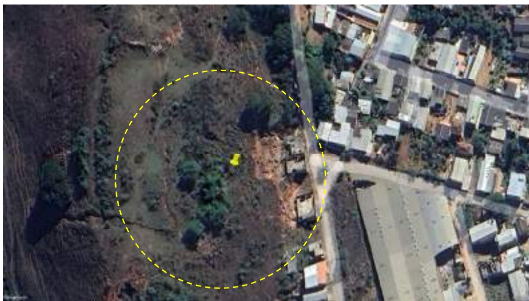
Figura 15 - Talude localizado na Rua João Afonso. Fonte: Google Earth.
