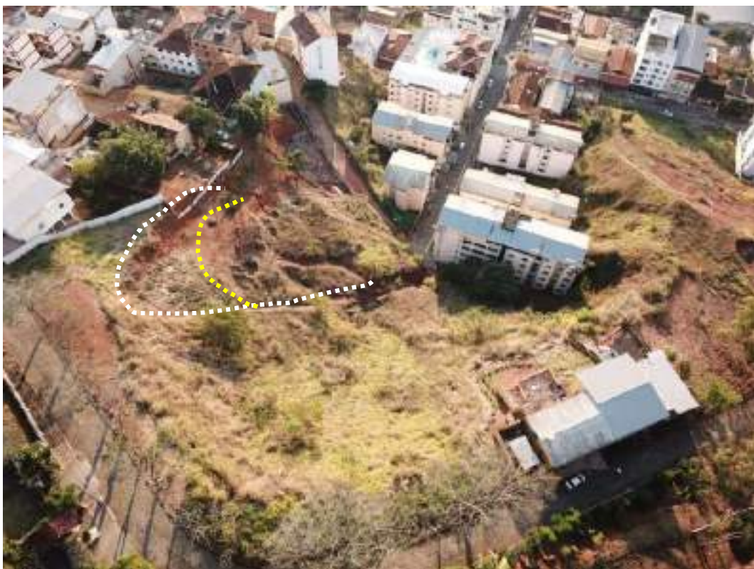
Figura 13 - Vista superior da área com marcações das trincas antigas em branco e recentes em amarelo. Fonte: Defesa Civil de Ponte Nova-MG.
