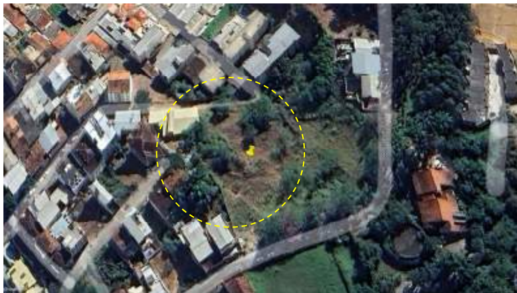
Figura 9 - Talude localizado na Rua Cid Gomes. Fonte: Google Earth.
