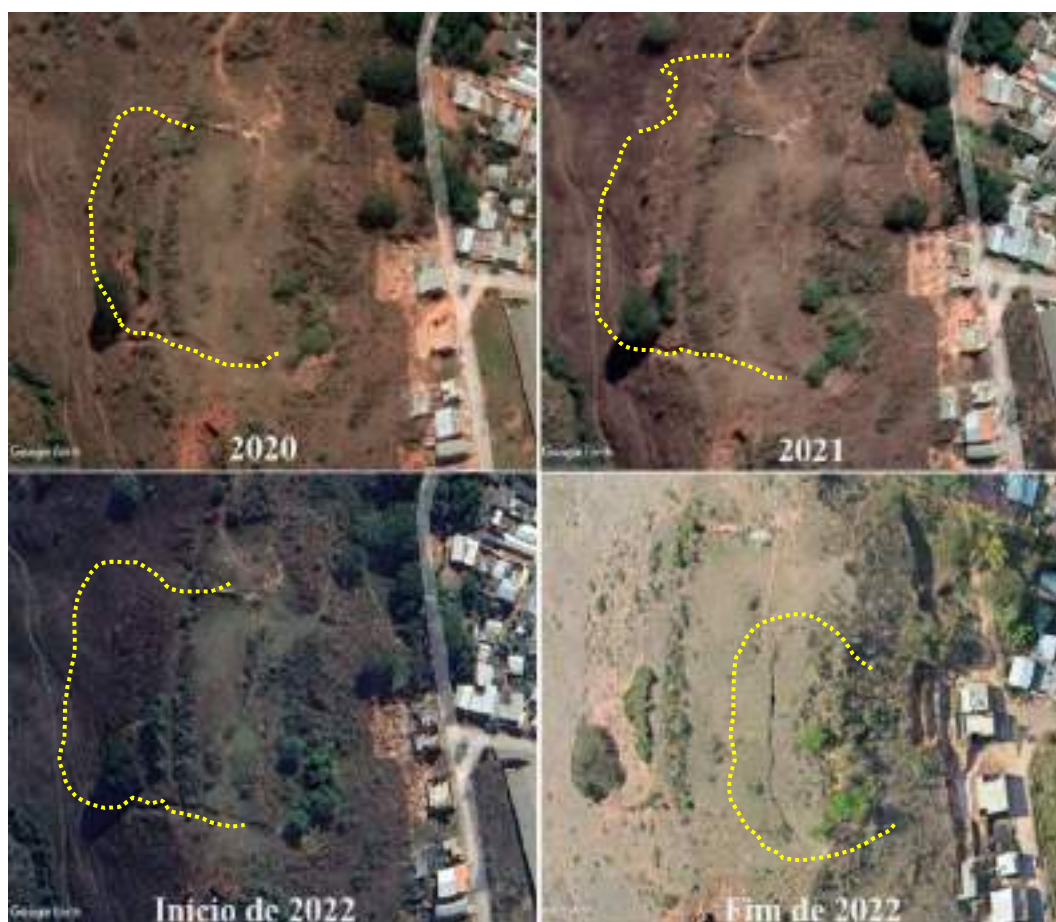
Figura 16 – Série histórica – Talude na Rua João Afonso – Anos de 2020 a 2022. Fonte: Google Earth.
