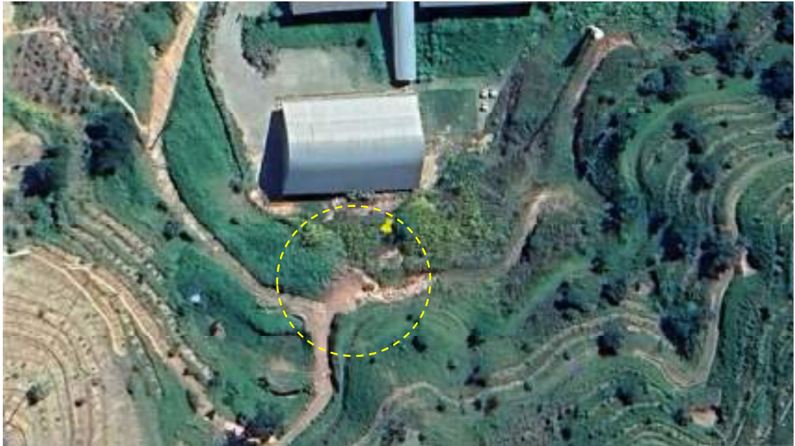
Figura 19 - Talude localizado no Parque do Cristo. Fonte: Google Earth
