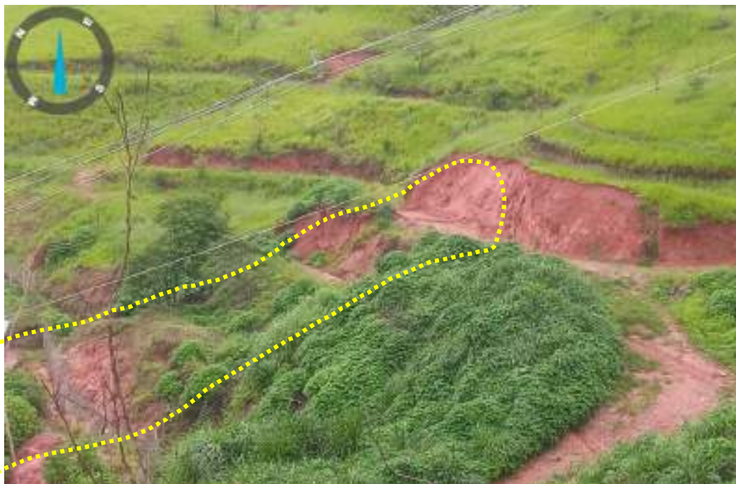
Figura 21 - Vista Lateral do talude rompido. Fonte: Defesa Civil de Viçosa-MG.
