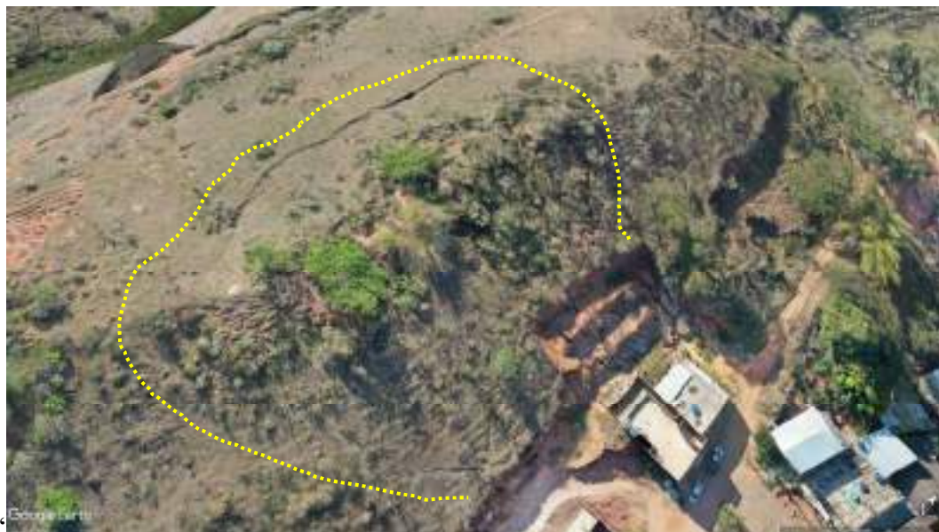
Figura 17 - Ortofoto do talude na Rua João Afonso – Vista em Perspectiva - Fim do ano de 2022. Fonte: Defesa Civil de Ponte Nova-MG.
