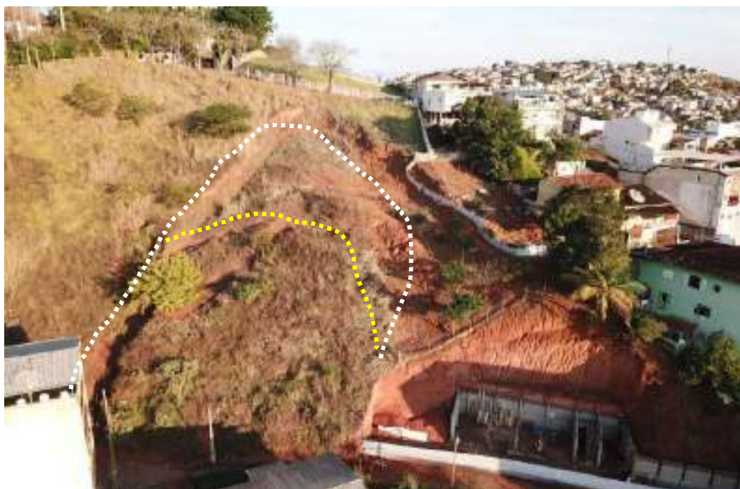
Figura 11 - Vista frontal do local com superfícies de rupturas antigas em branco formando o contorno maior e as trincas recentes internas em amarelo. Fonte: Defesa Civil de Ponte Nova-MG.
