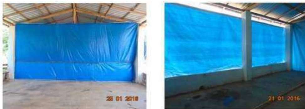
Figura 12 – Fechamento de todas as laterais da área escolhida com lona de aviário.
