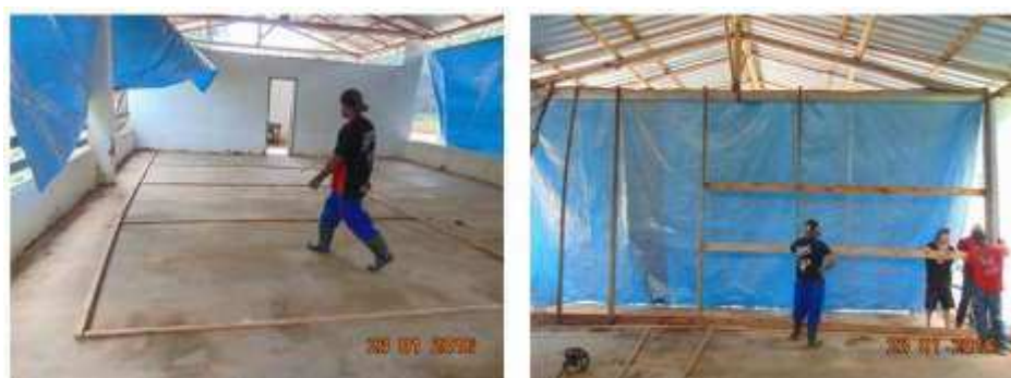
Figura 13 – Construção da estrutura em ripas para obtenção do forro.
