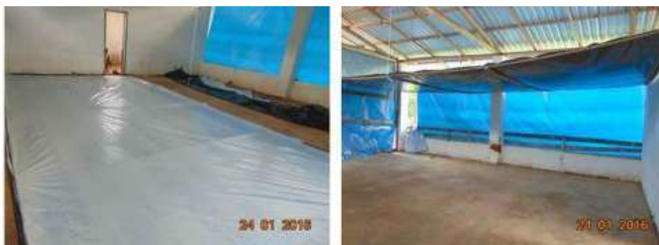
Figura 14 – Alocação da lona na estrutura do forro.
