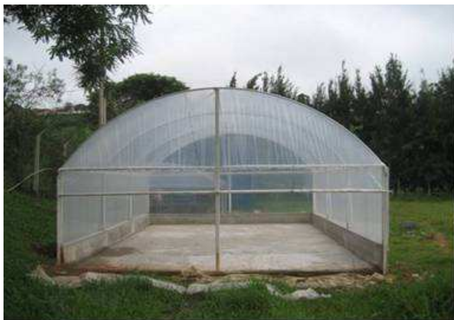
Figura 2 – Estufa agrícola para solarização de lodos, ETE Violeira, Viçosa, MG.
