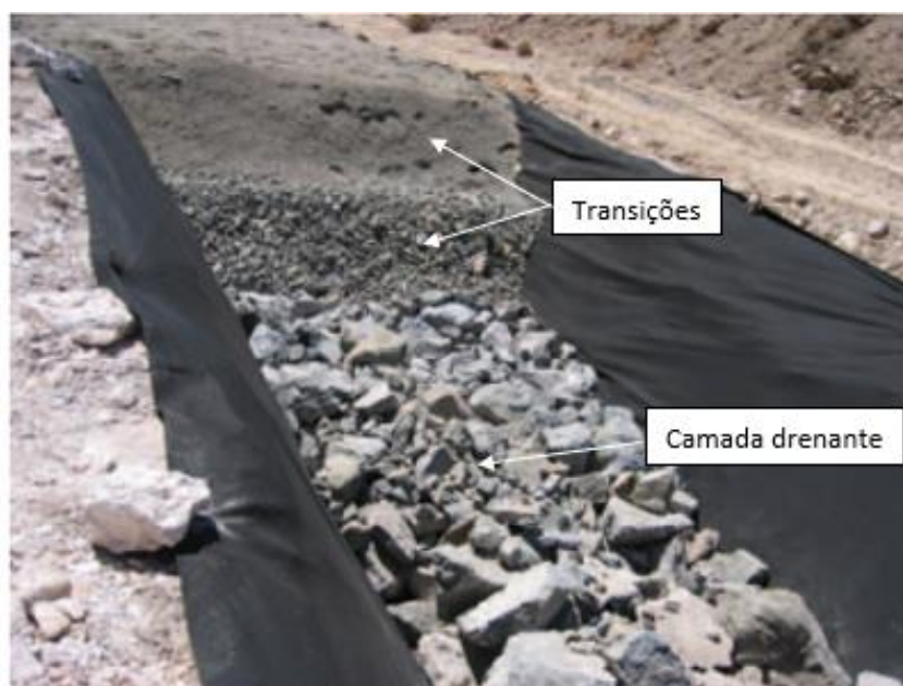
Figura 4-1 - Dreno de fundo de pilha
