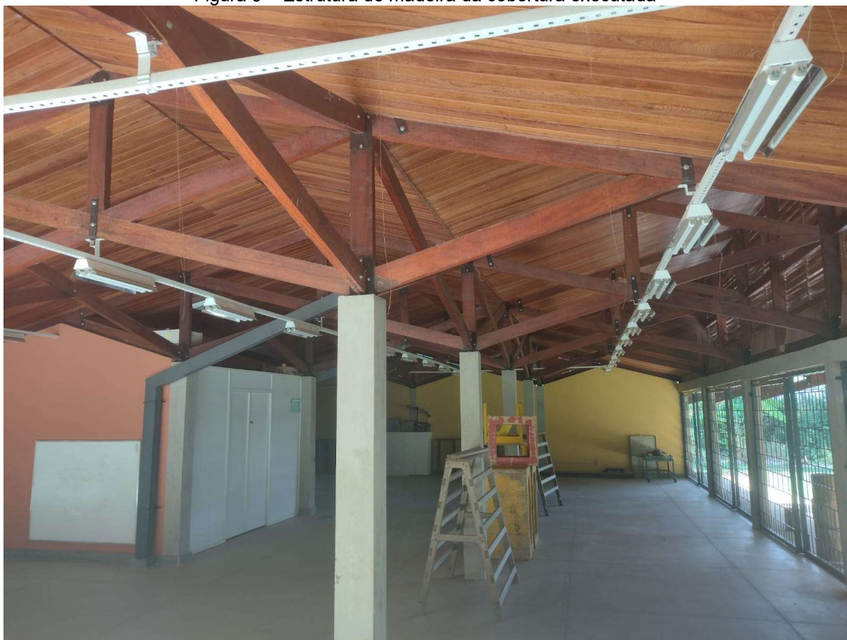
Figura 9 – Estrutura de madeira da cobertura executada
