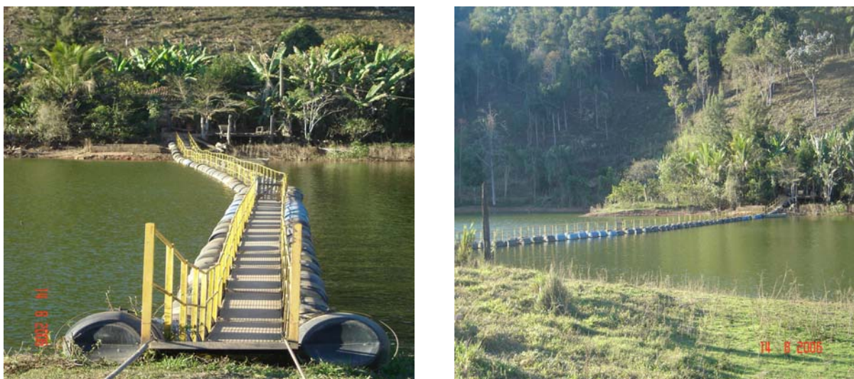
Figura 5 - Foto da passarela, em duas perspectivas, que leva o acesso da propriedade à estrada de Bicuíba. (Fonte: autoria própria)
