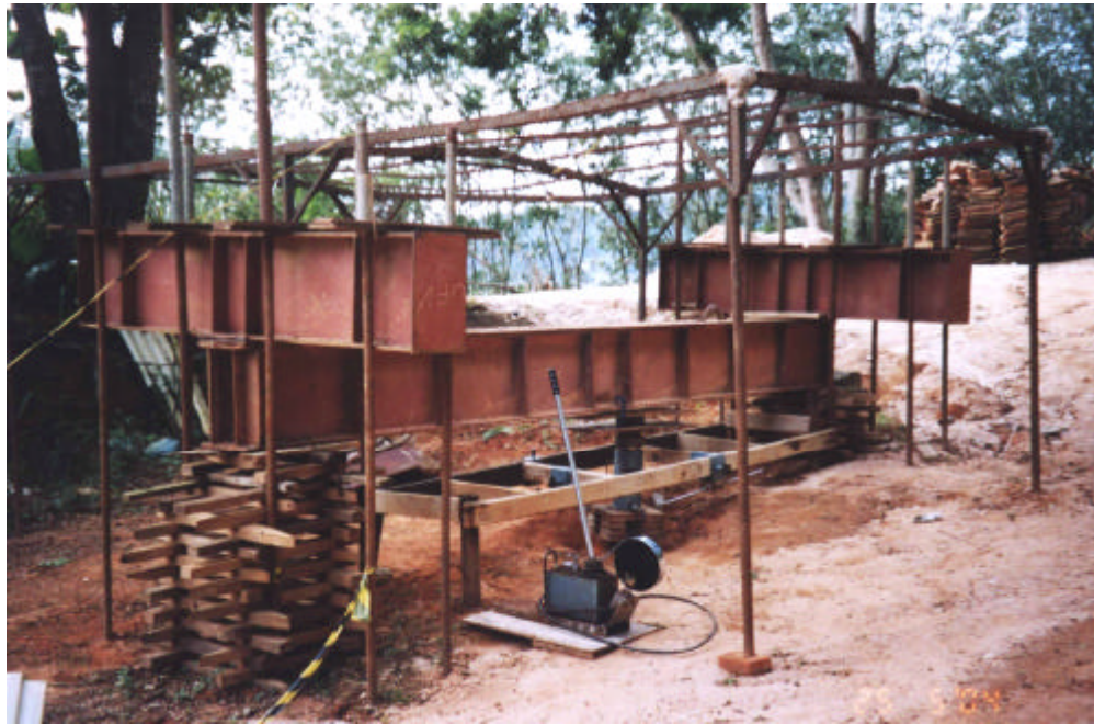
Figura 3.10 Montagem da prova de carga.
