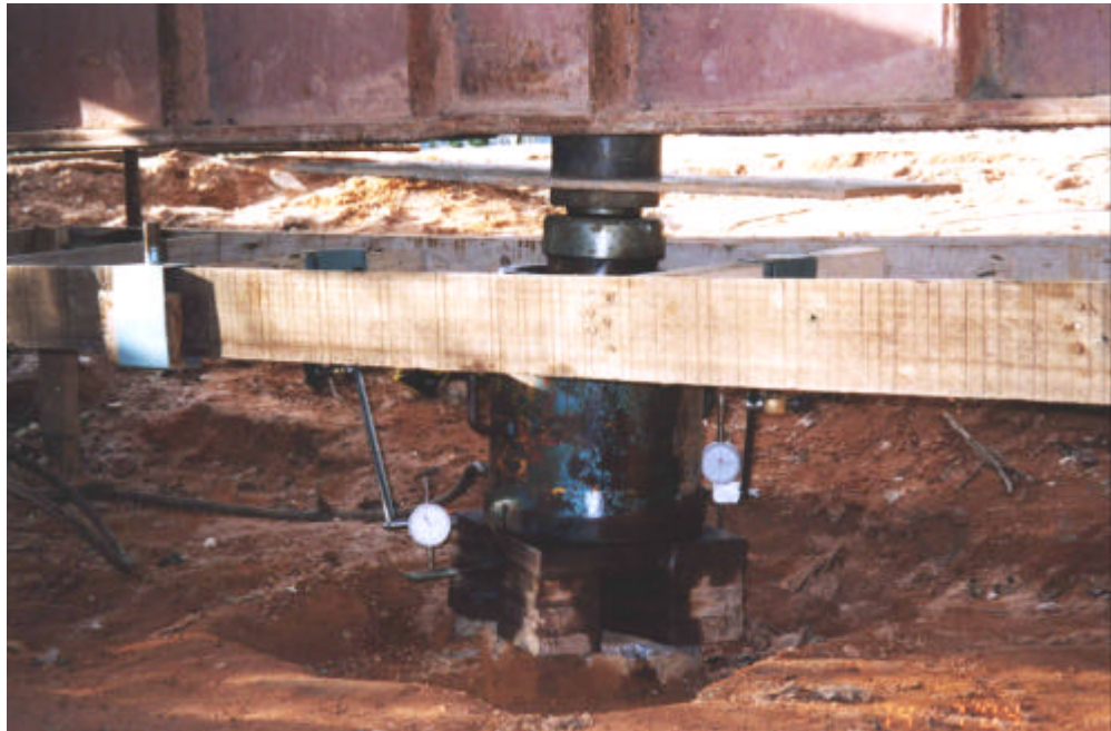
Figura 3.12 Instalação do macaco hidráulico de 2000 kN.
