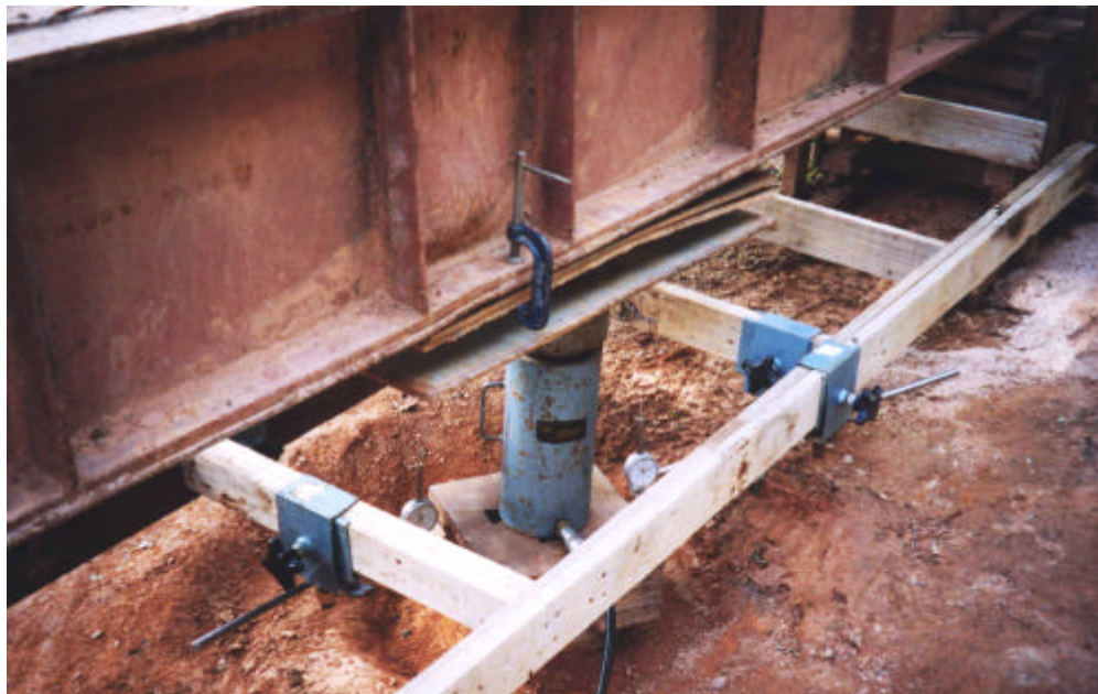
Figura 3.15 Viga de referência utilizada para fixação das hastes metálicas.
