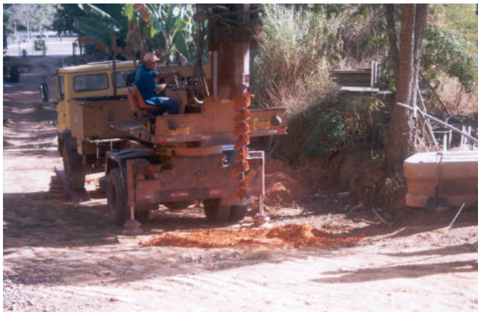
Figura 3.5 Escavação da estaca com trado mecânico.
