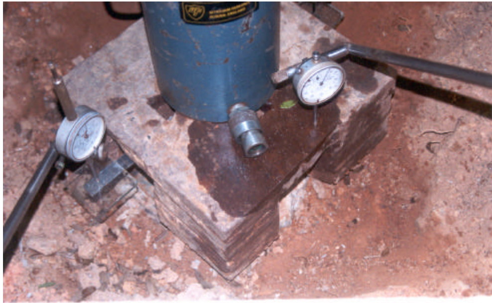
Figura 3.14 Detalhe da chapa de ferro para apoio do macaco hidráulico.
