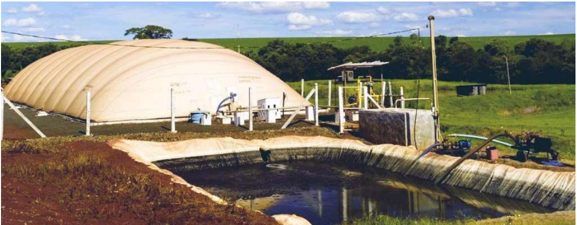
Figura 3.1 – Vista de um biodigestor real de fluxo tubular com manta plástica (Sinuelo, 2016).
