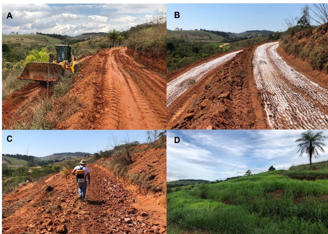
Figura 3 - Preparo dos terraços: Construção dos terraços (A); aplicação do calcário (B); semeio da Urochloa ruziziensis em terraço gradeado (C); terraços estabilizados (D)
