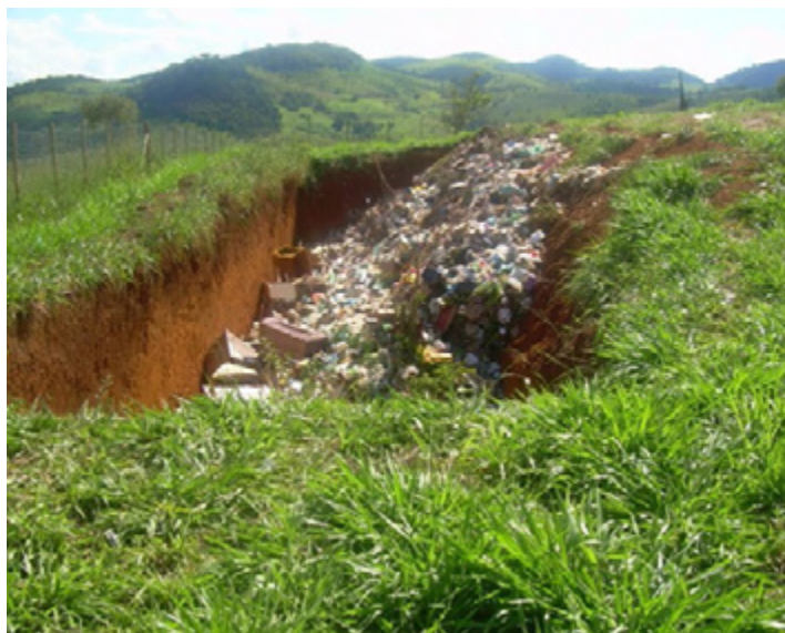
Figura 17 – Disposição dos resíduos na primeira vala construída no depósito de Bugre em 2009.
