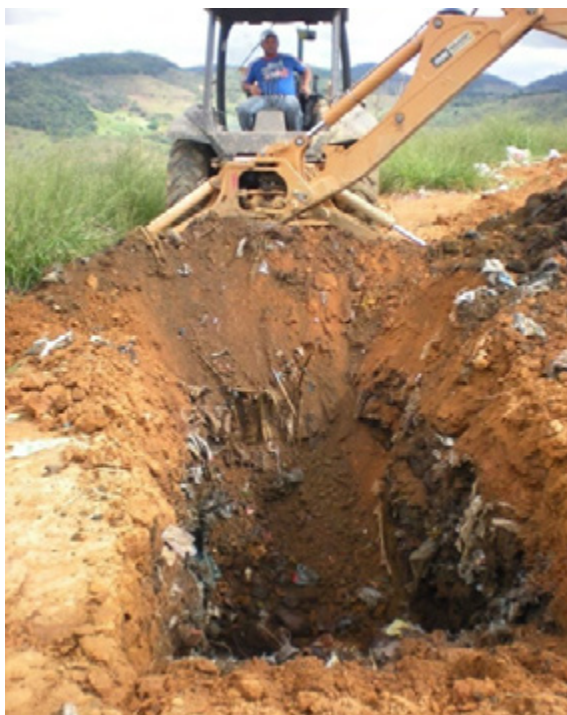
Figura 25 – Abertura da trincheira para coleta de amostras de solo sob as valas de disposição de resíduos.
