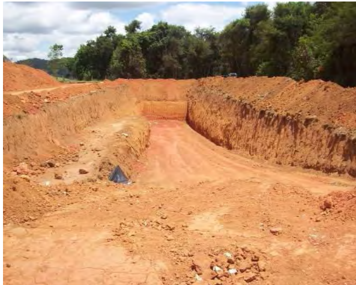
Figura 3 – Aterro Controlado. Fonte: Fundação Israel Pinheiro, 2010.
