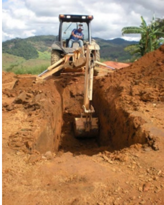
Figura 23 – Abertura da trincheira para coleta de amostra de solo para ensaios geotécnicos.
