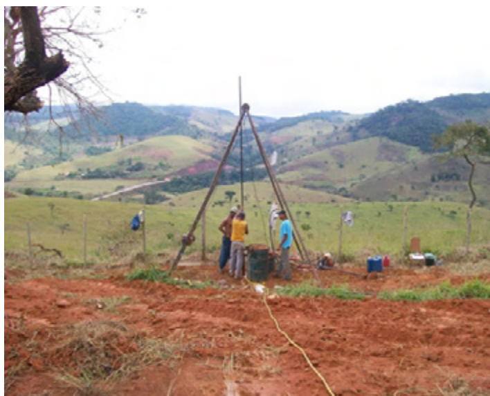
Figura 22 – Execução de sondagem SPT.
