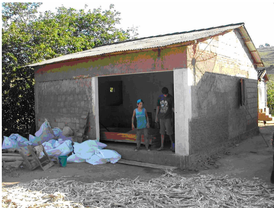
Figura 4.1. Depósito e sede da ARPRAM.
