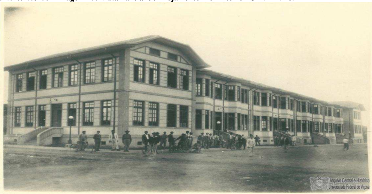
04.01.02.03-06 - Imagem 25: Vista Parcial do Alojamento-Dormitório ESAV – 1928.
