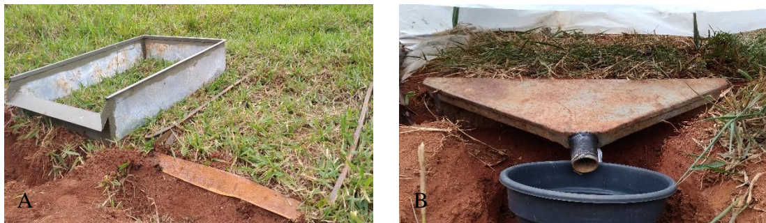
Figura 1. Parcelas de aço galvanizado em processo de instalação no solo (A) e detalhe da calha coletora de escoamento superficial (B).
