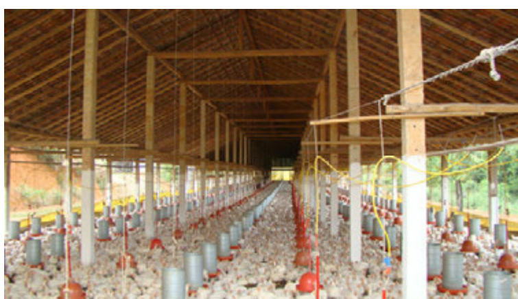
Figura 54. Vista interna do galpão de aves de corte em Canaã, Minas Gerais
