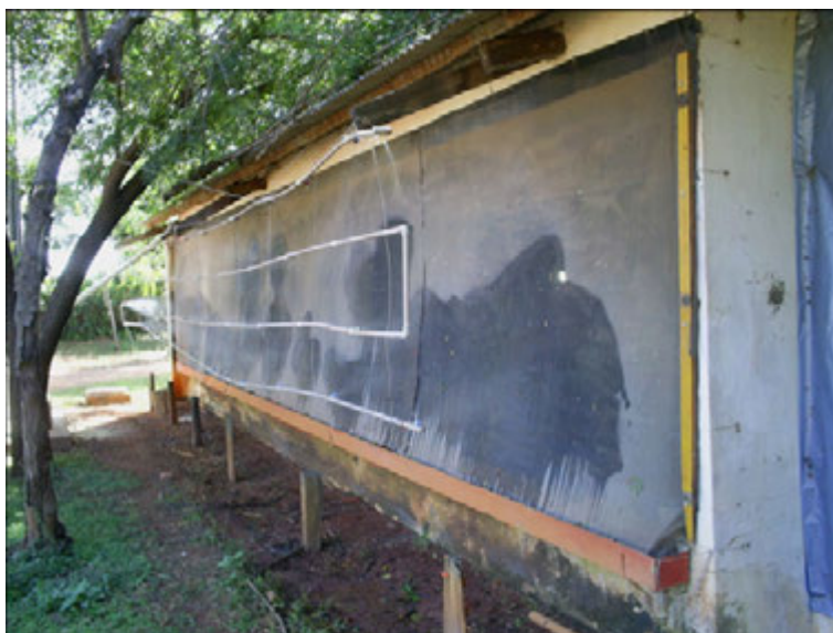
Figura 35. Vista externa do sistema de resfriamento com placas umedecidas cobertas com sombrite do galpão de aves de corte em Itaberaí, Goiás
