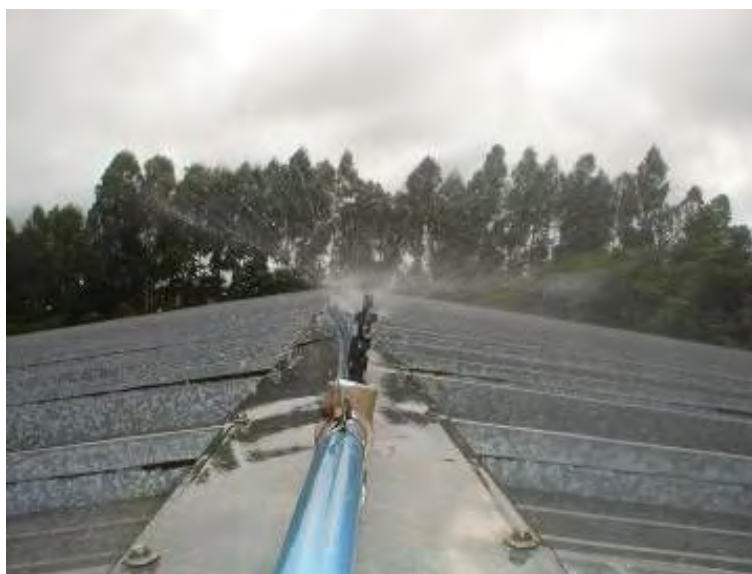
Figura 24. Vista superior do sistema de aspersão sobre a cobertura dos galpões de aves de corte em Rio Verde, Goiás
