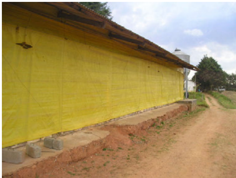
Figura 43. Vista externa da cortina do galpão de frangos de corte em Barbacena, Minas Gerais
