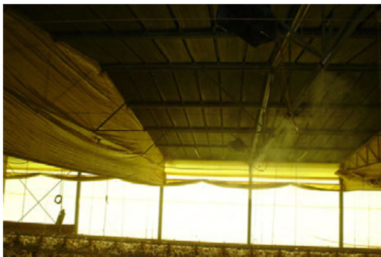
Figura 13. Vista do sistema de nebulização interno do galpão de aves de corte em Rio Verde, Goiás
