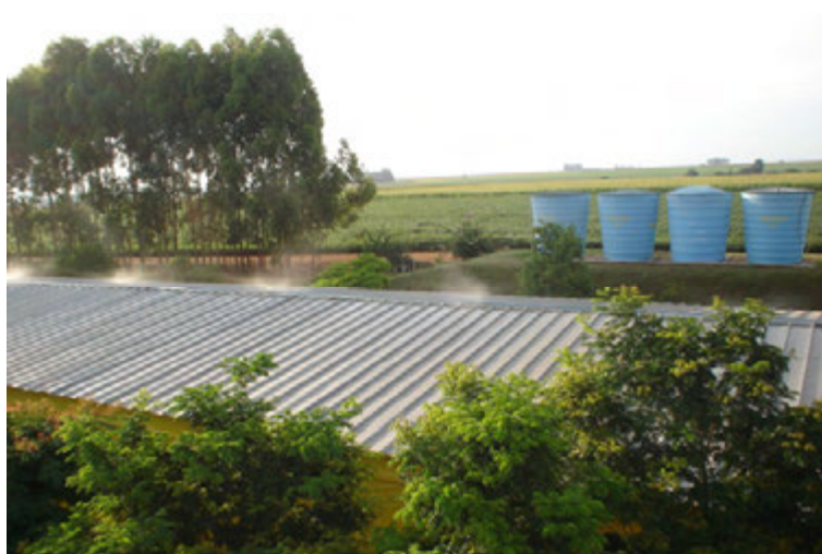
Figura 23. Vista do sistema de aspersão sobre a cobertura dos galpões de aves de corte em Rio Verde, Goiás
