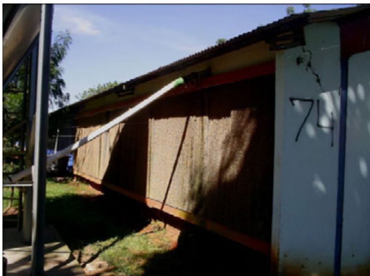
Figura 34. Vista externa do sistema de resfriamento do galpão de aves de corte em Itaberaí, Goiás
