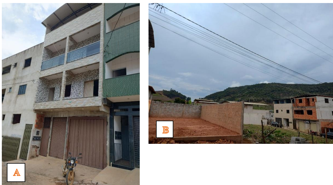
Figura 18- Construções com mais de dois pavimentos e casas em construção
