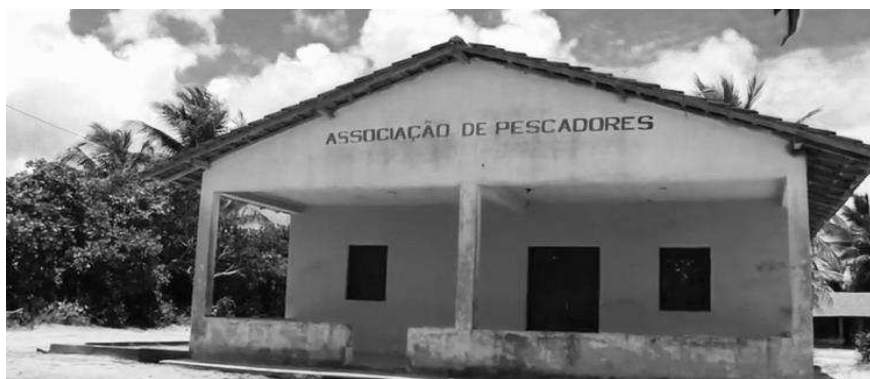
Figura 18: Sede da Associação de Pescadores da comunidade de Veleiro, Fonte: Gidelberto dos Santos, 2004.
