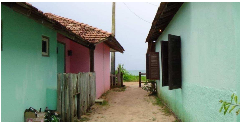
Figura 29: Casas na comunidade de Corumbau. Fonte Luciana Perry, 2013.
