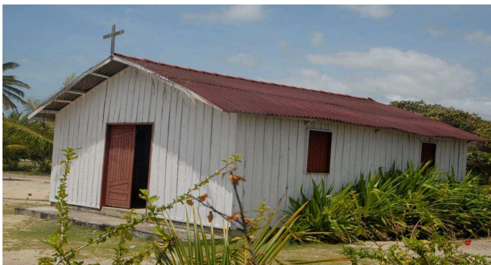
Figura 25: Igreja de Nossa Senhora Aparecida, na comunidade de Bugigão. Fonte: Carvalho, 2014, p. 57.
