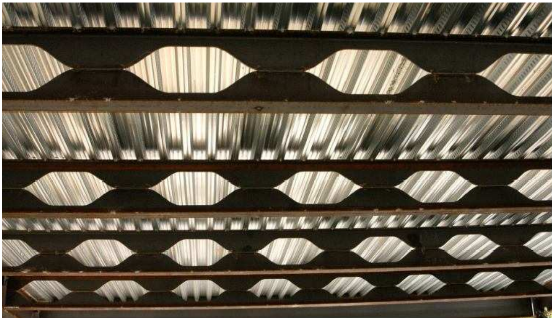
Figura 1.6 – Viga perfilada padrão Angelina™ (WALD et al. , 2010).
