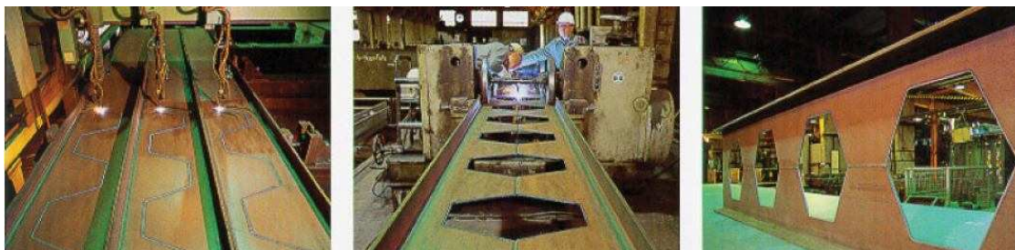
Figura 1.1 – Fabricação de vigas casteladas (GEMPERLE, 2007).
