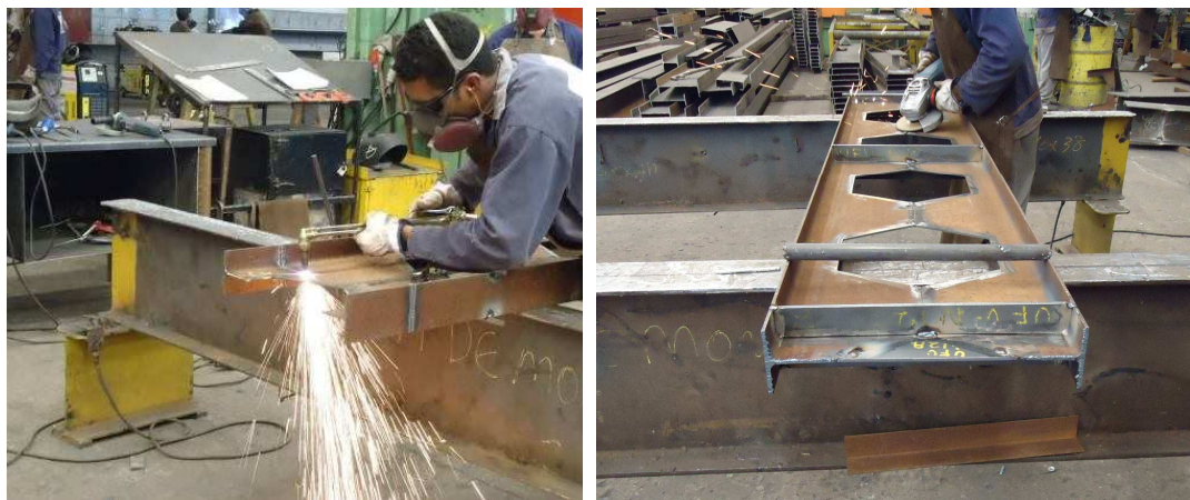
Figura 3.9 – Acabamento final das extremidades da viga castelada.
