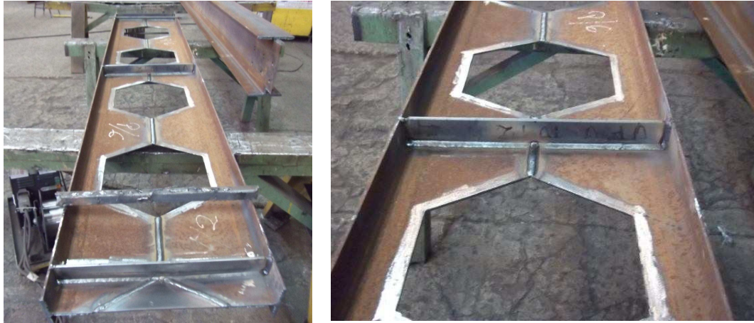
Figura 3.11 – Aspecto da viga após a soldagem final (foto: Gustavo Verissimo).
