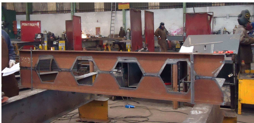
Figura 3.8 – Viga pré-montada com pontos de solda.
