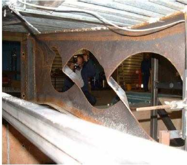
Figura 2.5 – Flambagem do montante de alma de uma viga celular mista (NADJAI et al. , 2008).
