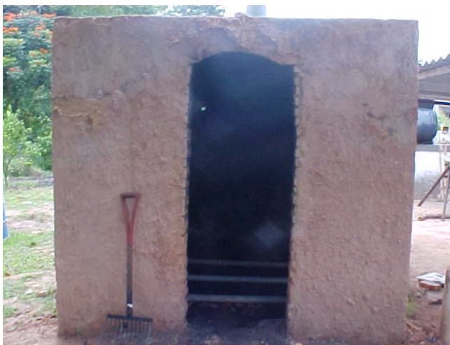
Figura 20 - Sistema de distribuição do vapor na base da massa de carvão, sendo (a) chegada do vapor, (b) distribuição longitudinal na base da massa de carvão e (c) orifício de saída do vapor.
