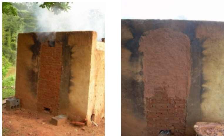
Figura 16 - Fechamento da porta do forno e colocação da massa de vedação.
