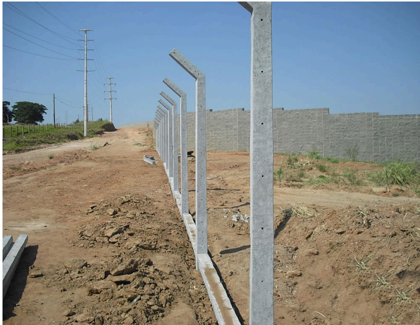
Figura 6 – Mourão de concreto.
