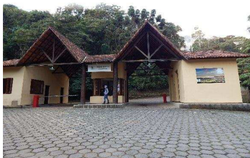
Figura 24 – Vista da Portaria do PNC em Alto Caparaó. Fonte: A autora (2015).
