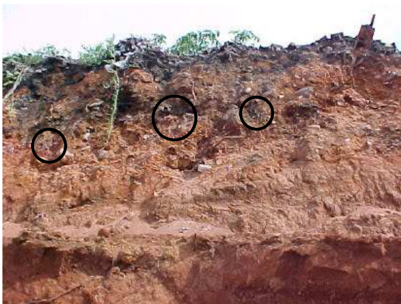
Figura 66 – Vista 1 da infiltração de chorume no solo sob o lixão de Viçosa.
