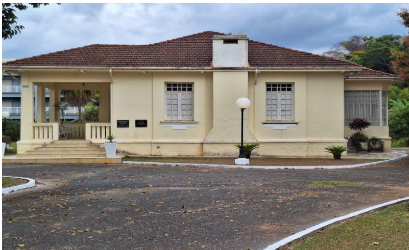
Figura 7 - Casa de hóspedes (antiga residência do vice-diretor da ESA)
