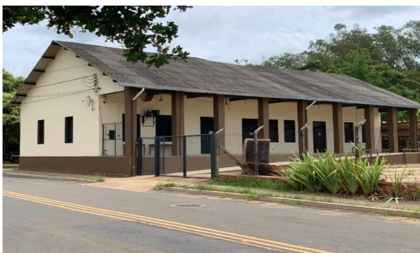
Figura 11 - Galpão que abriga Salas de Aulas da Agronomia
