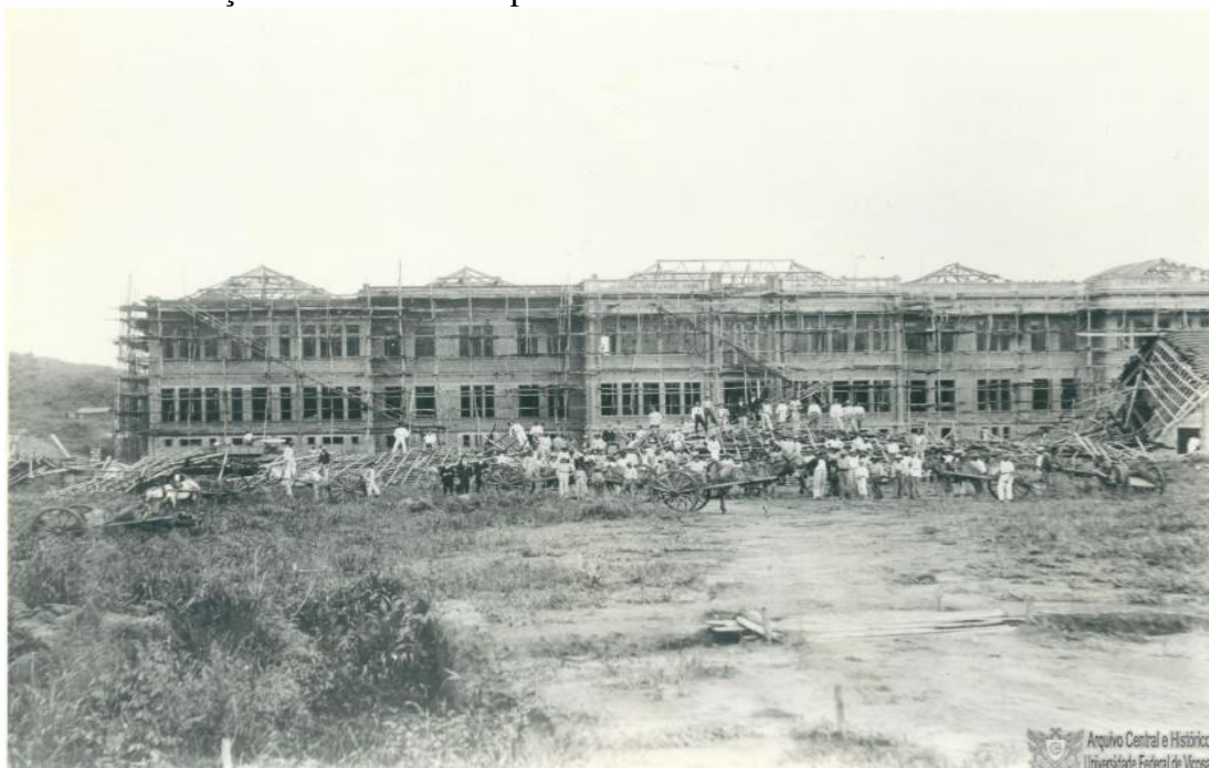
Figura 19 - Construção do Prédio Principal
