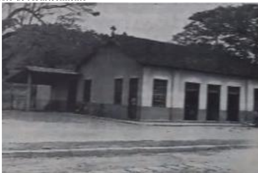
Figura 20 - Posto de Abastecimento
