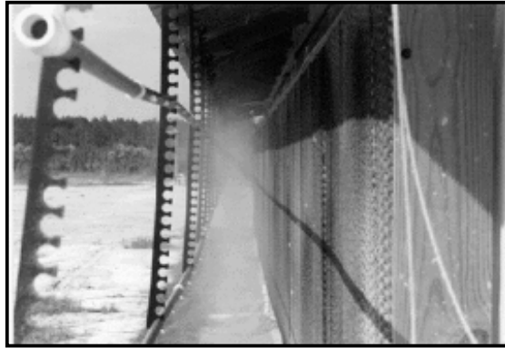
Figura 19 - Localização das linhas de nebulização de água direta nas placas.
