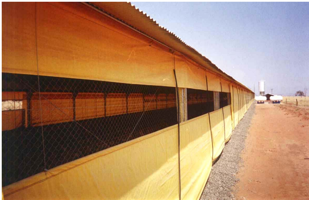
Figura 4A - Vista da entrada de ar no tratamento SE.
