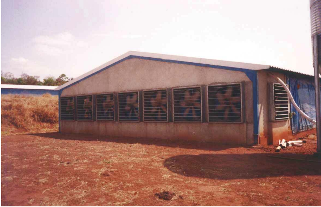
Figura 5A – Vista dos exaustores no tratamento SE.
