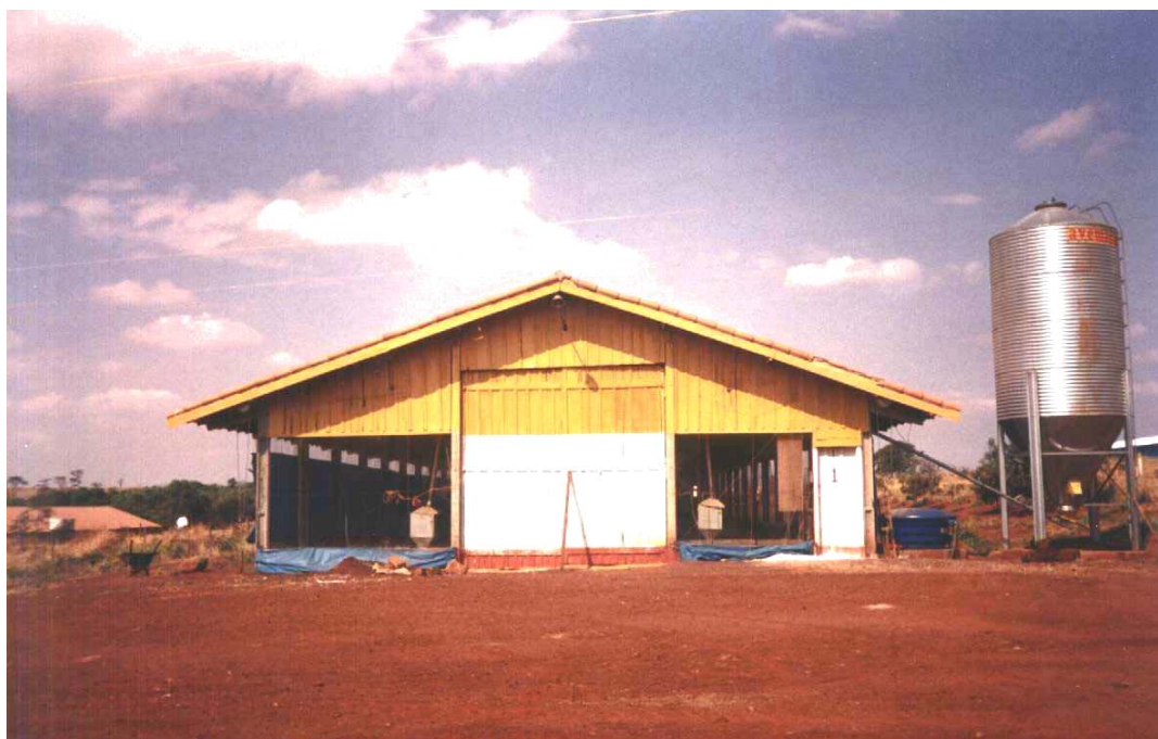
Figura 2A – Vista da entrada de ar no tratamento SV.
