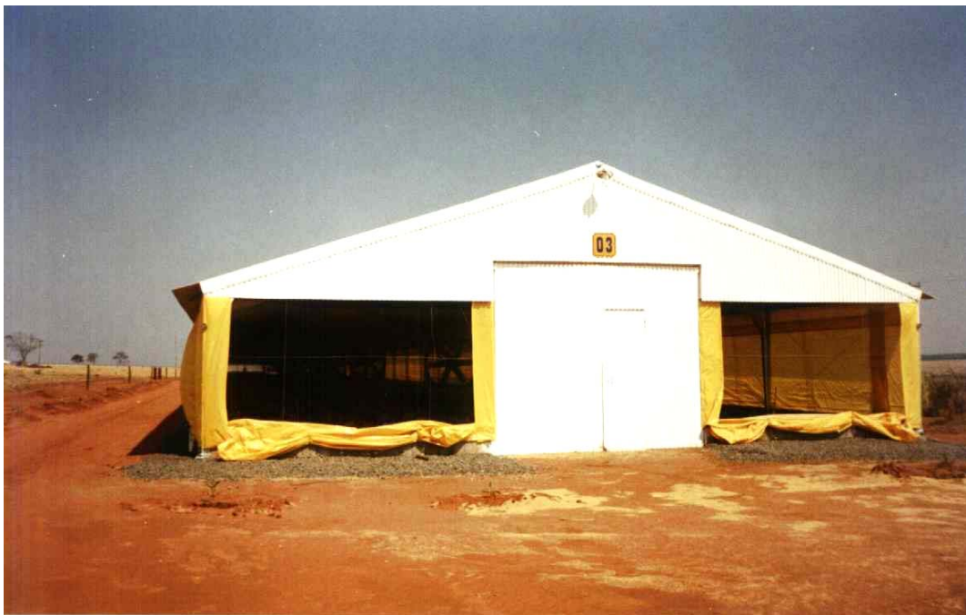
Figura 6A - Vista da entrada de ar no tratamento SV.
