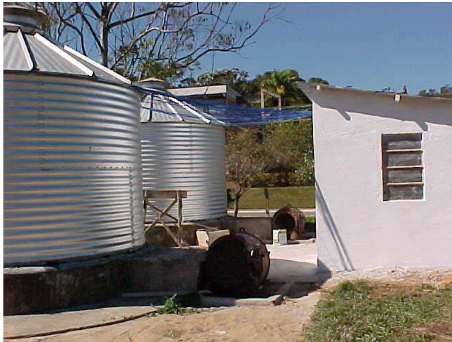
Figura 1A – Visão externa do silo e da casa de comando.
