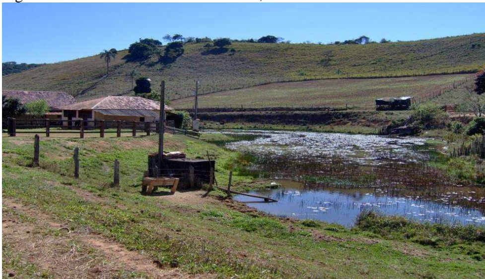
Figura 6 – Imóvel construído sobre APP, Coimbra/MG.
