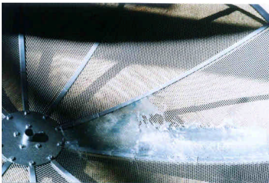
Figura 24 – Espelhamento cobrindo-se a superfície com massa plástica, em seguida polida e pintada com tinta reflexiva.
