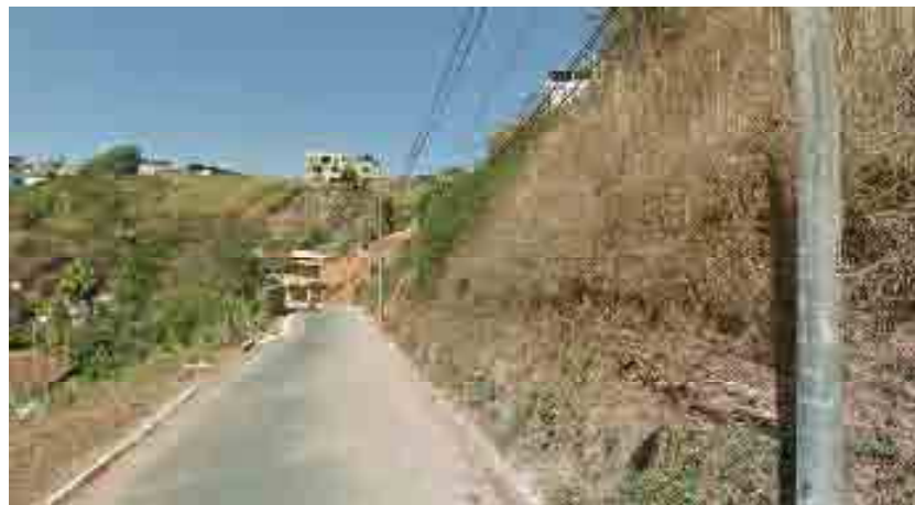
Figura 7.8 – Local onde foi realizado o ensaio PMT-08 – Rua José Santana, B. Santa Clara. Na figura (a) tem-se a vista do topo para a base do talude, no detalhe, trecho que houve escorregamento; em (b) tem-se a vista a partir do ponto do ensaio para o topo; em (c) tem-se a vista a partir da base do talude analisado, antes do mesmo romper.
