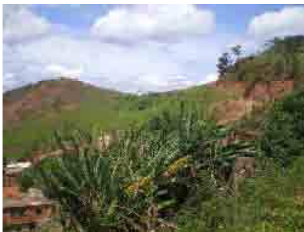
Figura 7.6 – Local onde foi realizado o ensaio PMT-06 – estrada Nova Viçosa-Posses, B. Nova Viçosa. Na figura (a) tem-se a vista do topo do talude, onde foi realizado o ensaio.; em (b) e (c) tem-se vistas do talude com sua inclinação considerável.
