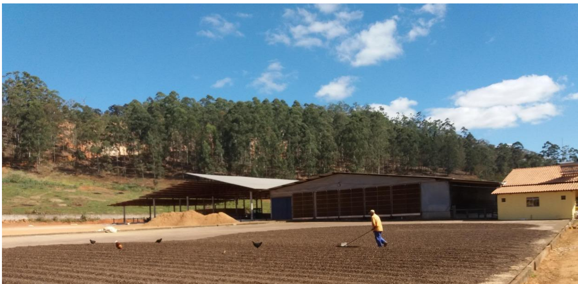
Figura 4 - Proximidade entre os galpões do tipo Compost Barn analisados
