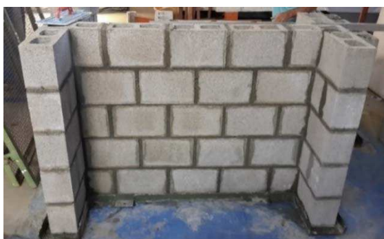
Figura 3-36 – Primeira etapa do painel de alvenaria executada
