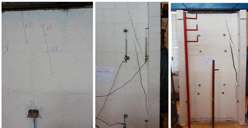
Figura 4-13 - Início das microfissuras e abertura de fissuras na alma (Painel 1)
