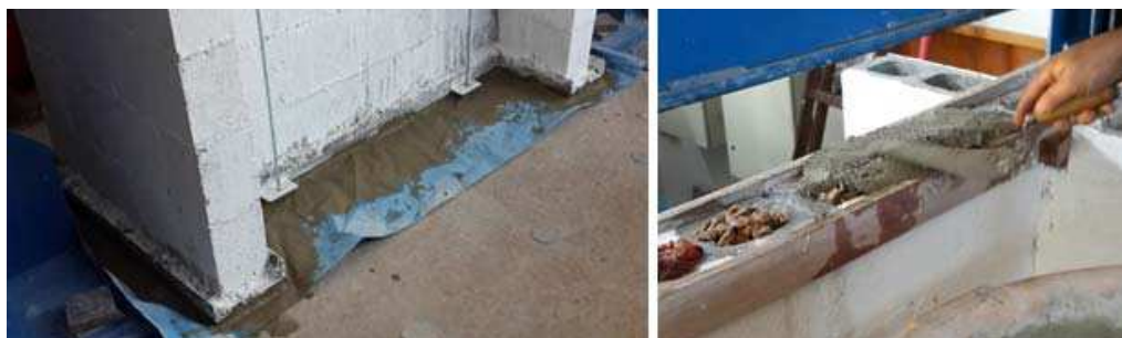
Figura 3-43 –Capeamento realizado na base do painel e na sua última fiada
