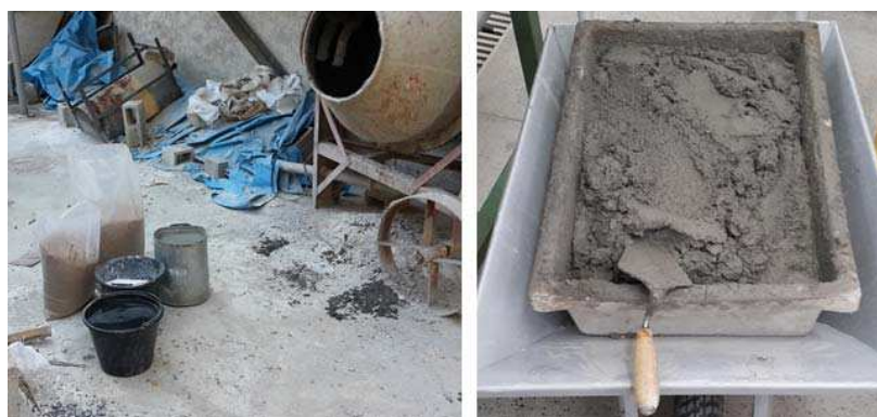
Figura 3-34 – Preparação e transporte da argamassa
