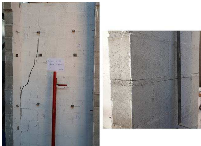
Figura 4-25 - Início das microfissuras e abertura de fissuras na alma e aba (Painel 5)
