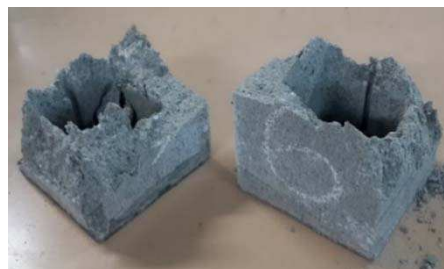
Figura 4-3 Modo de ruptura do meio bloco, região de esfacelamento
