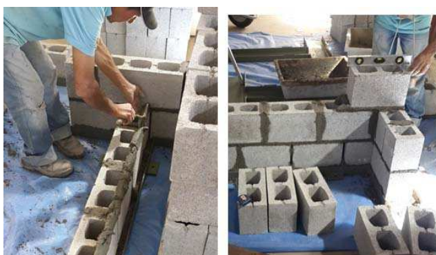
Figura 3-35 – Primeira etapa do painel de alvenaria executada
