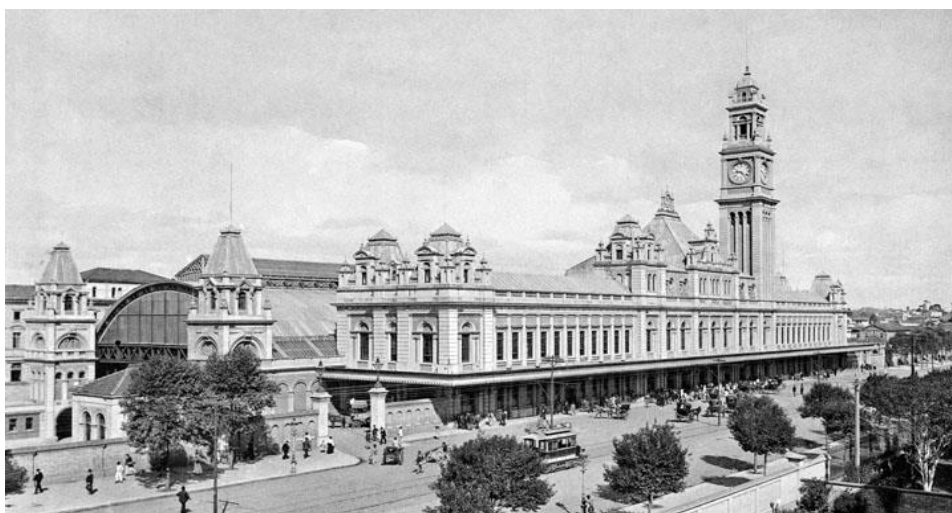
Figura 3: Estação da Luz reformada
