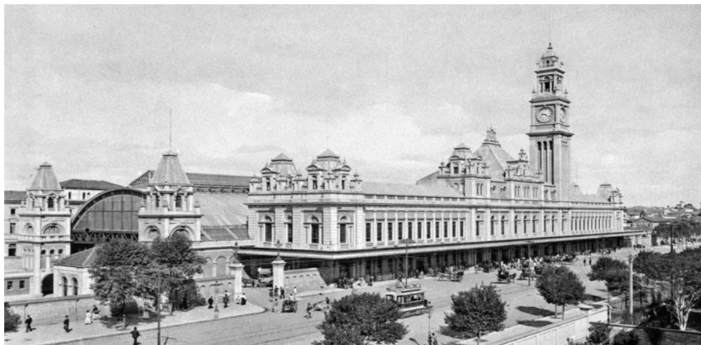
Figura 1: Estação da Luz reformada
