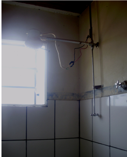
Figura 9 - Instalação de misturadores de água na casa da COHAB-Piedade de Caratinga, 2010. Fonte: autor.
