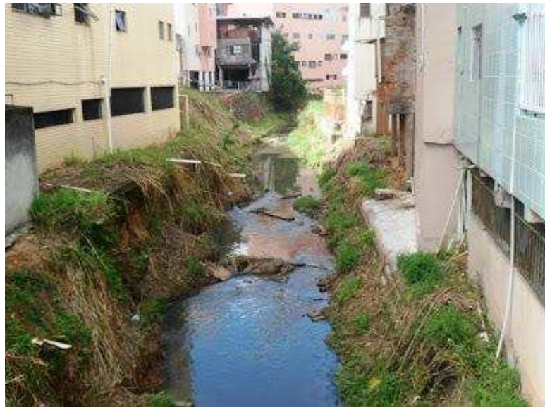
Figura 20 – Lançamento de esgotos e construções na calha do ribeirão São Bartolomeu, na área central de Viçosa. Fonte: Ítalo Stephan, 2015.
