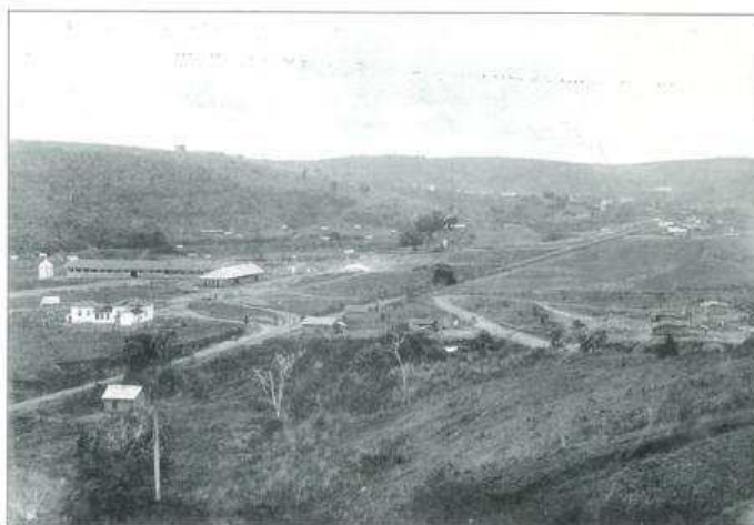
Figura 7 – Início das obras da ESAV, 1922. Fonte: Sabioni, 2006, p.48
