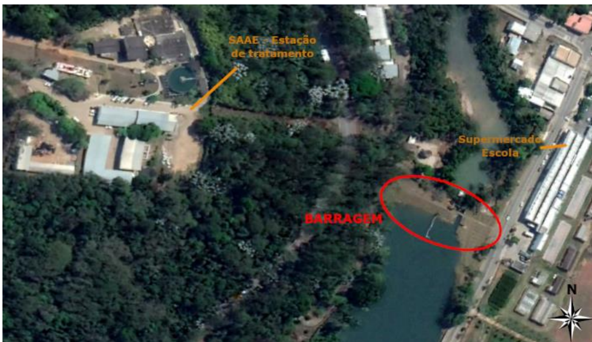
Figura 33: Vista aérea da barragem e do seu entorno.
