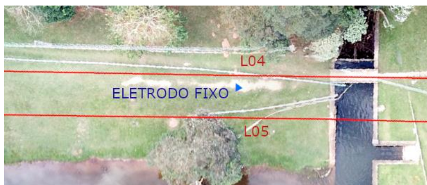
Figura 44: Vista aérea da barragem, com destaque para a posição do eletrodo fixo.
