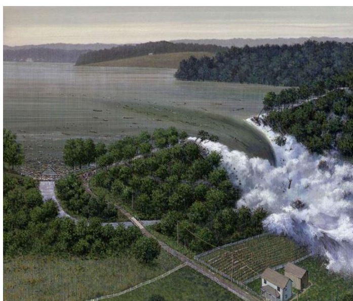
Figura 2: Exemplo de ruptura por galgamento.
