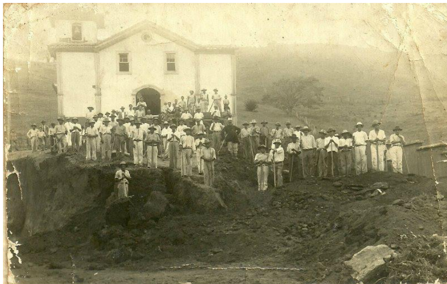
FIGURA 5 - Desaterro para a construção da nova igreja Matriz de São Sebastião. Fonte: Acervo fotográfico do Museu “Casa do Bentoca”.
