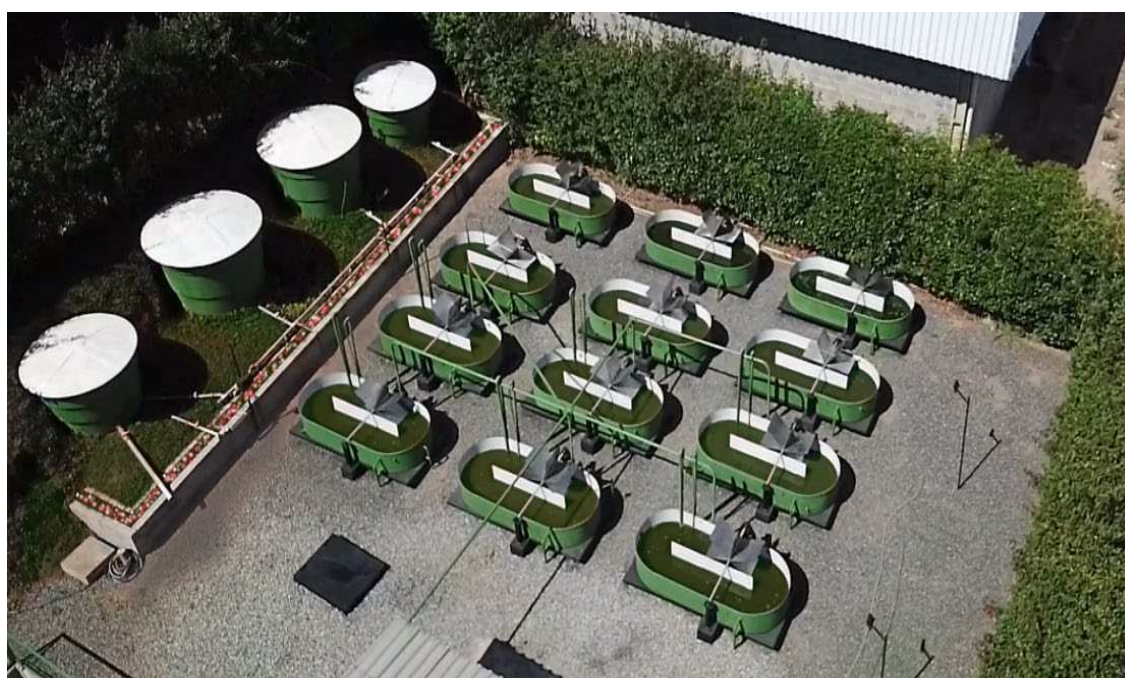
Figura II: Lagoas de alta taxa instaladas no Laboratório de Engenharia Sanitária e Ambiental da Universidade Federal de Viçosa.
