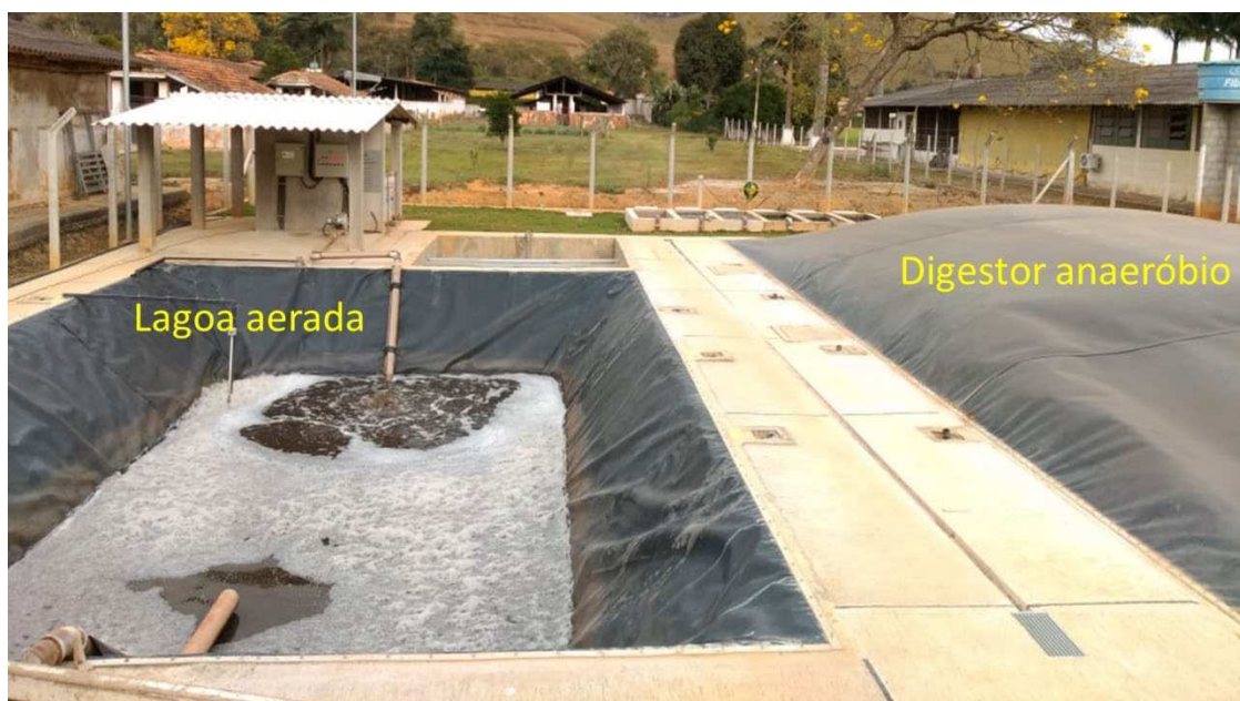
Figura I: Estação de tratamento da água residuária da suinocultura instalada na Unidade de Ensino, Pesquisa e Extensão em Suinocultura da Universidade Federal de Viçosa.
