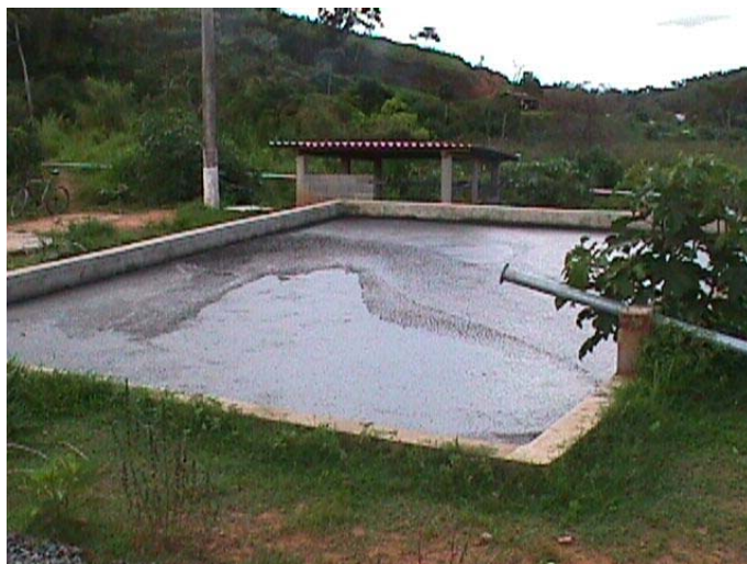
Figura 3. Vista parcial do tanque de armazenagem da água residuária da suinocultura e da casa de bombas (ao fundo)
