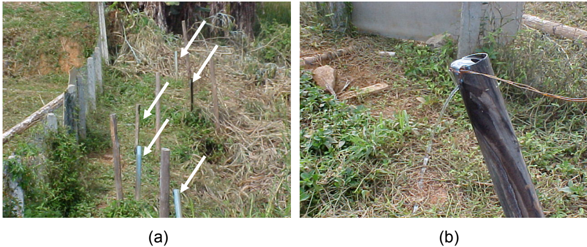
Figura 12. Vista geral dos tubos de drenagem posicionados ao final de cada SAC (a) e detalhe de um tubo onde foi coletado o efluente dos SACs (b)
