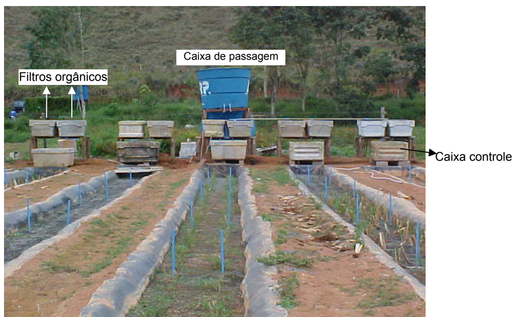
Figura 6. Vista parcial da montagem dos sistemas alagados construídos e do sistema de aplicação da água residuária
