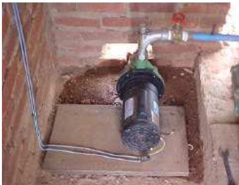
Figura 3B – Componentes (motobomba e componentes de filtragem) do sistema de irrigação utilizados na condução do experimento de maracujazeiro amarelo.
