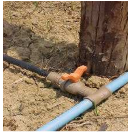
Figura 2B – Tomada de pressão de serviço (PS) do sistema e registro globo.
