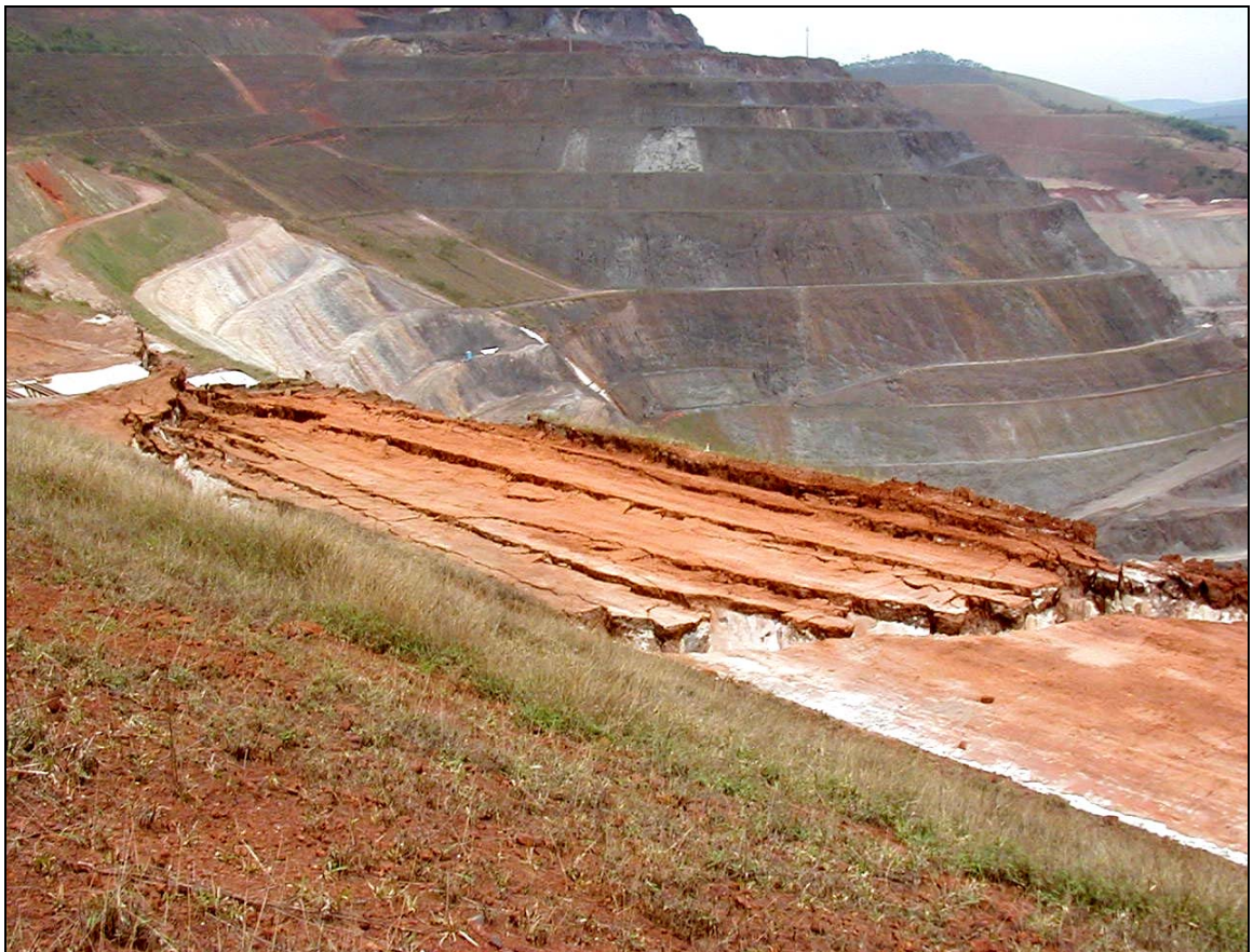
Figura 3.7: Ruptura localizada na porção superior do talude
