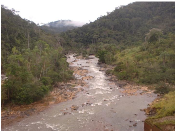
Figura 18 - Afloramento de rocha a jusante do barramento da PCH Pipoca (MG).
