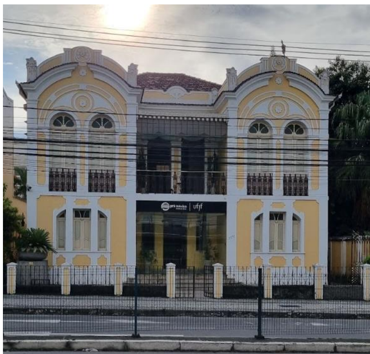
Figura 34 – Sede do Pró-Música, onde funciona o CeR-LGBTQI+
