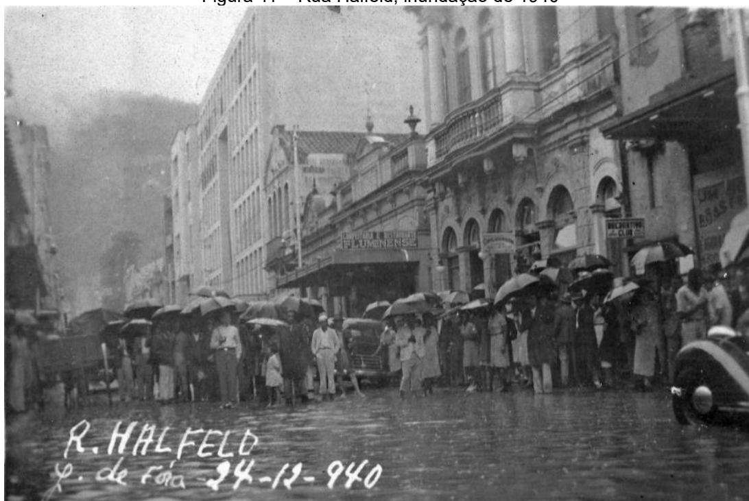
Figura 11 – Rua Halfeld, inundação de 1940
