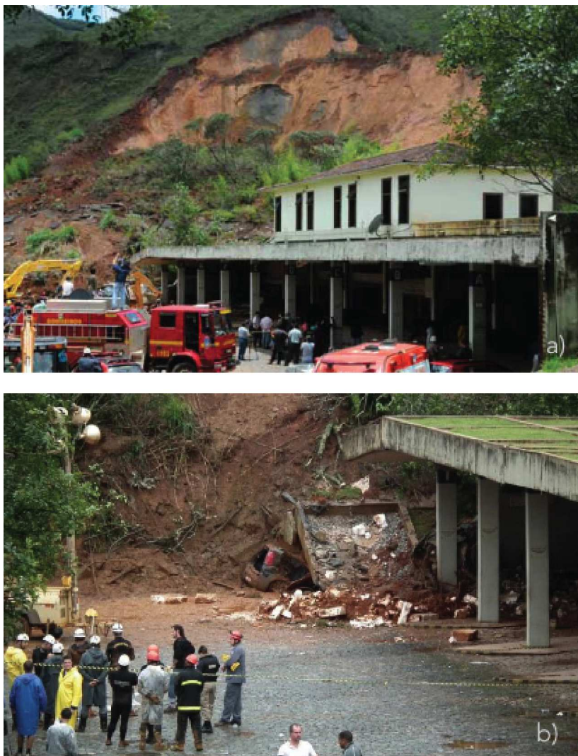
Figura 40 - Deslizamento no bairro São Francisco
