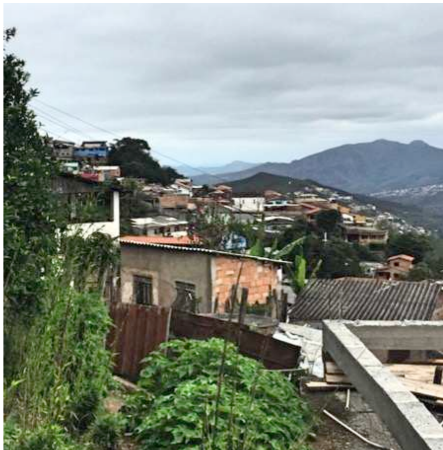
Figura 15 - Ocupação de encostas em Ouro Preto, vista do bairro Piedade - MG
