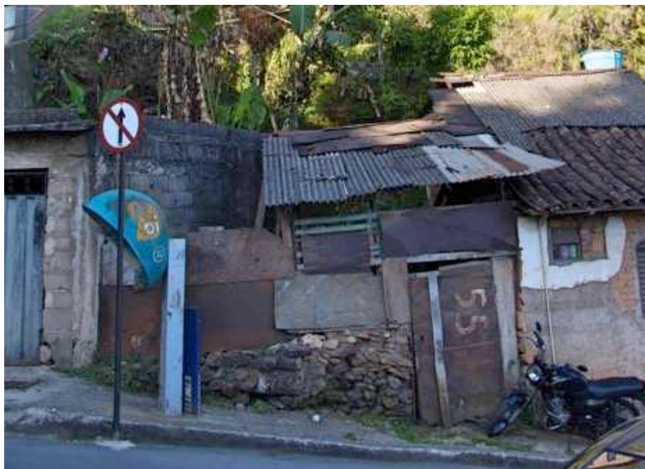
Figura 1 - Edificação no bairro São Cristóvão - Ouro Preto/MG
