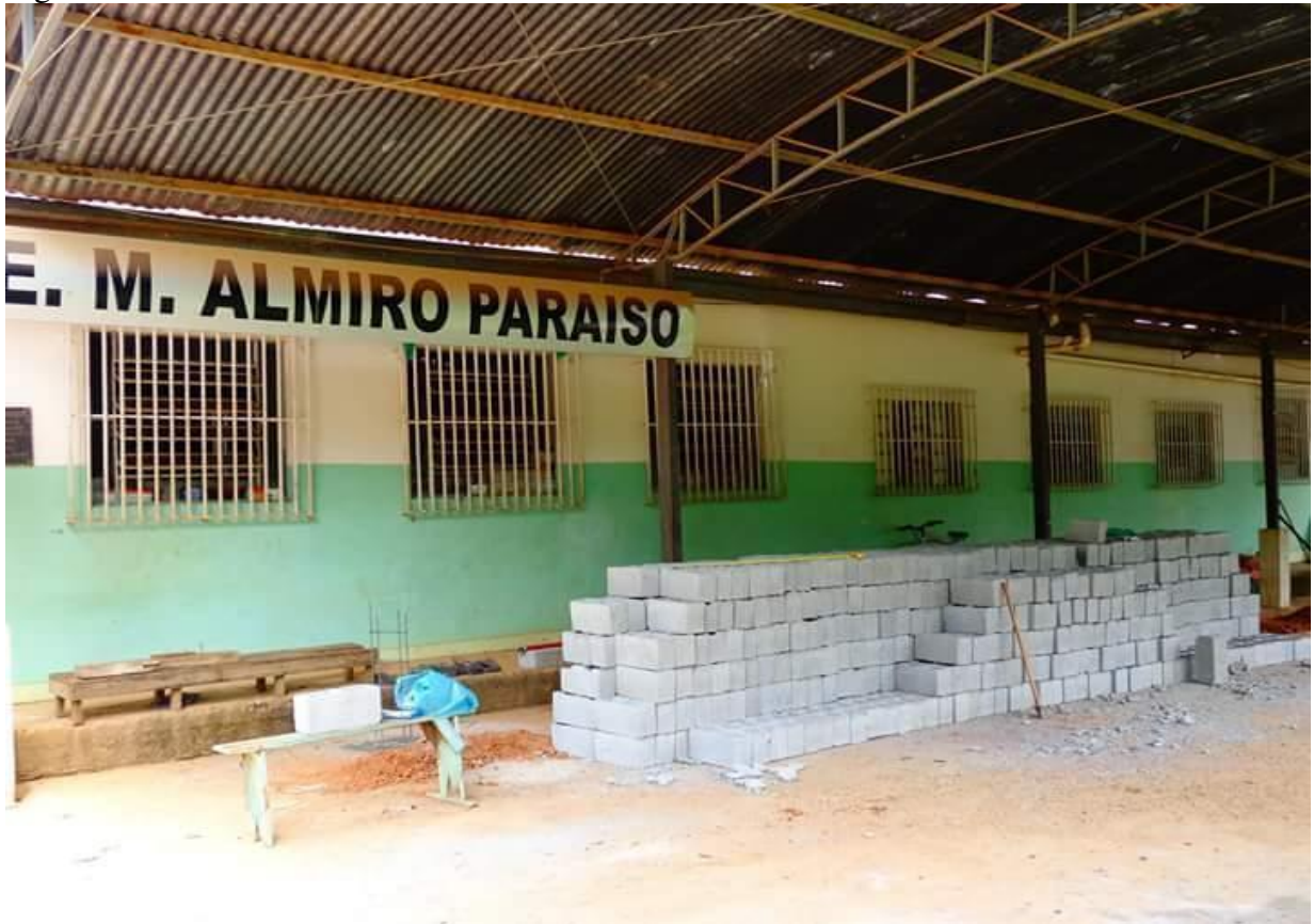
Figura 3 – Reforma da Escola no ano de 2016
