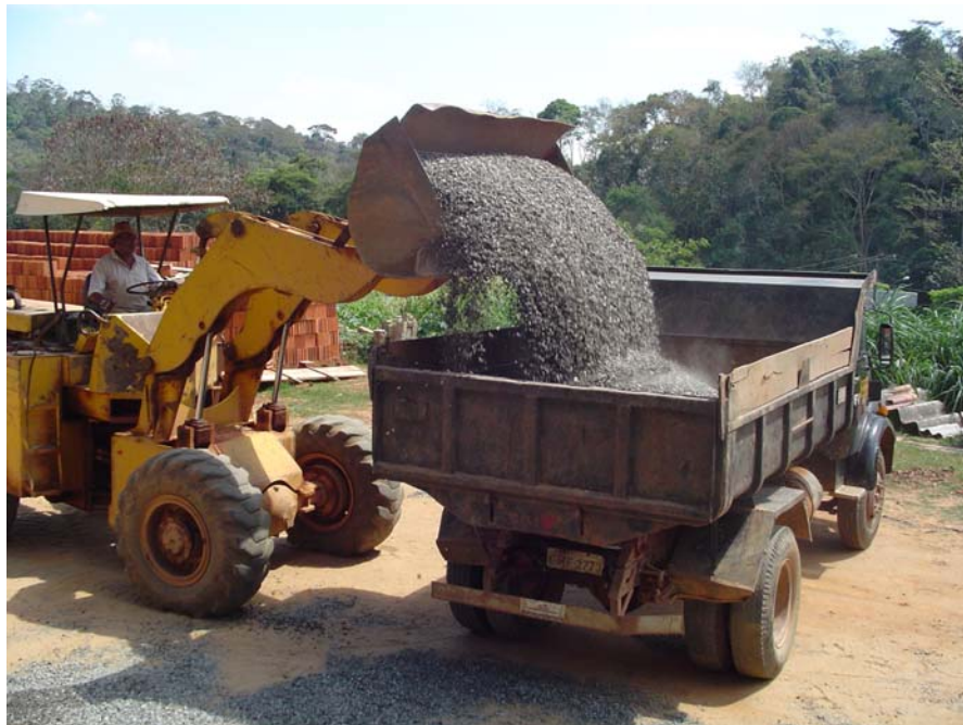
Figura 3.4 – Colocação de brita na caçamba do caminhão.
