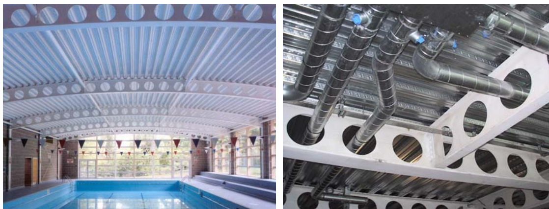
Figura 7 - Vigas alveolares permitem vencer grandes vãos e facilitam a integração com instalações e sistemas de forro (foto:WESTOK).
