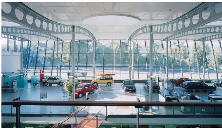
Figura 8 - Aspecto estético das vigas alveolares, que conferem um forte apelo arquitetônico (foto: CMC Steel Products).
