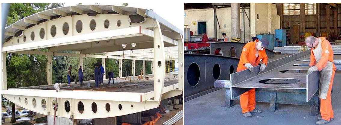
Figura 9 - Viga alveolar obtida a partir de perfil soldado, empregada no edifício sede da empresa Bruning Tecnometal, Panambi - RS (foto: www.metalica.com.br ).
