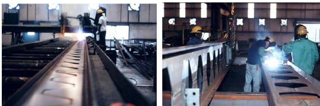
Figura 4 – Processo de corte e soldagem de vigas alveolares.
