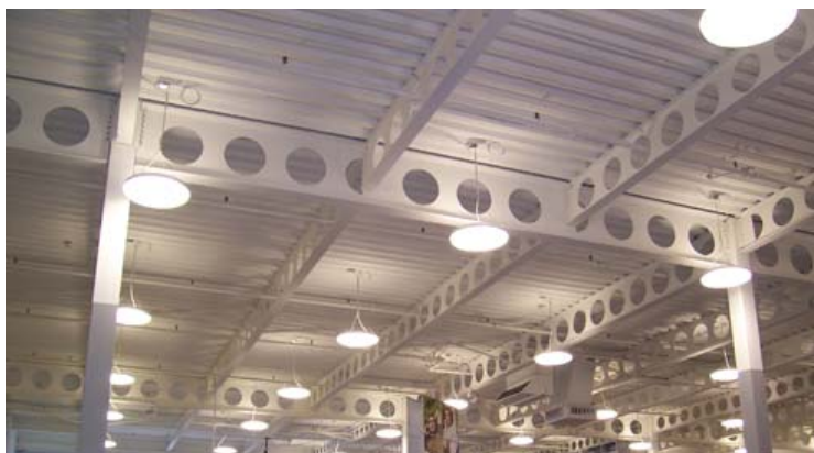
Figura 22 – Detalhe do fechamento das aberturas nas regiões onde as vigas secundárias se apóiam sobre as vigas principais (foto: CMC Steel Products).
