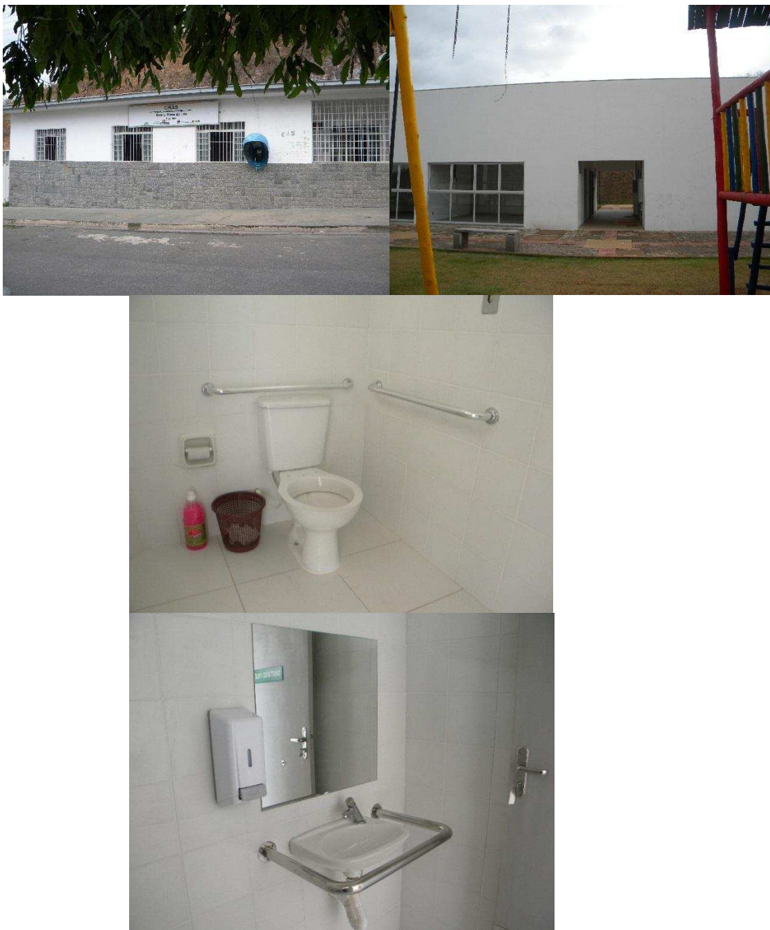
Figura 15: CRAS Pires da Luz – Ubá; sede atual (acima e à esquerda) e sede em construção (acima, à direita e abaixo), detalhes dos banheiros com acessibilidade, conforme as normas da ABNT. Fonte: Dados da pesquisa (2014).
