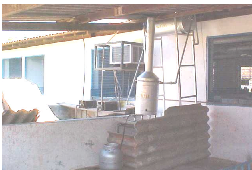
Figura 5 – Montagem do sistema de aquecimento de água.
