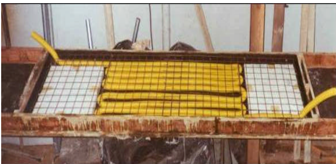
Figura 3 – Conjunto completo de fôrma, armação, tubos corrugados e blocos de isopor para confecção da placa P 2 .
