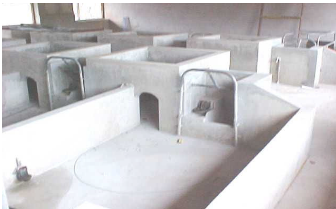
Figura 2 – Vista interna da sala da maternidade.
