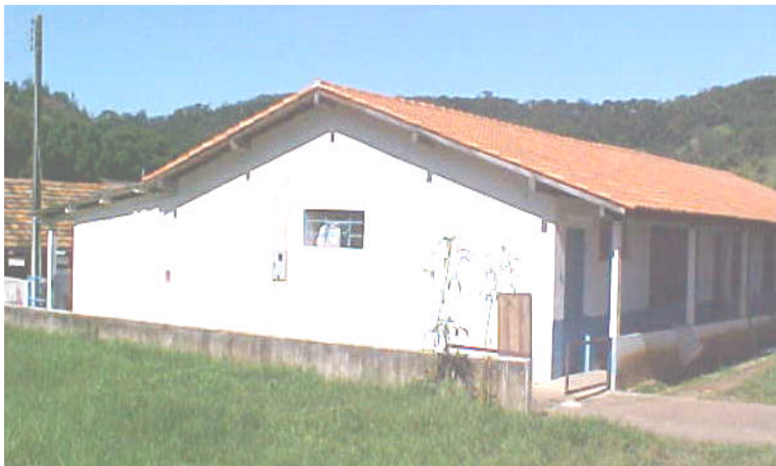
Figura 1 – Vista externa do galpão de maternidade.
