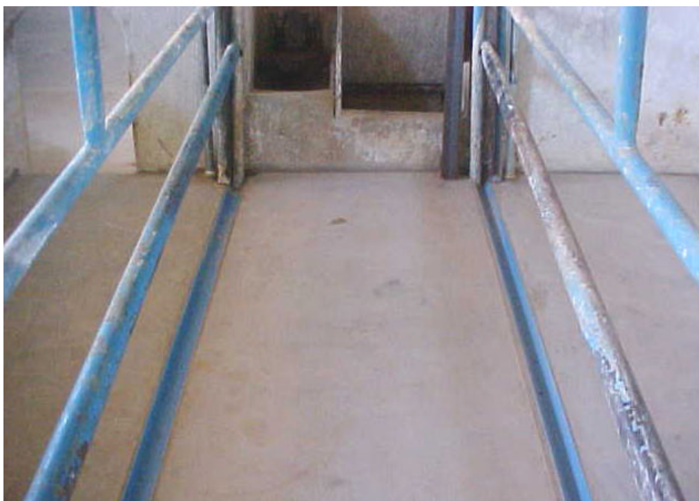
Figura 3 – Conjunto das placas montadas sobre o piso das baias da maternidade.
