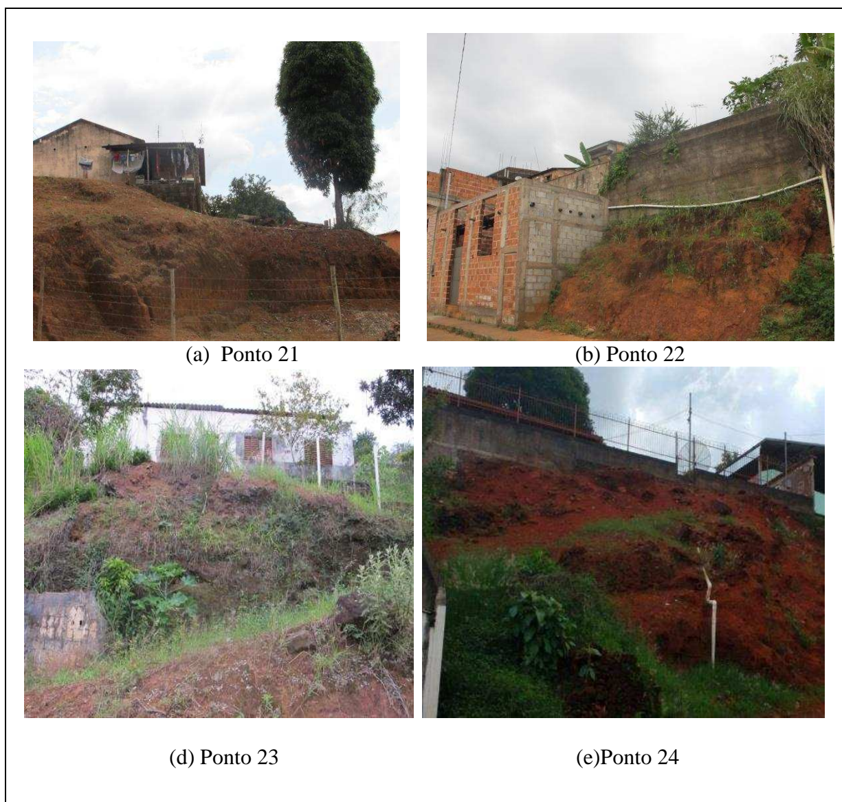
Figura 56. Pontos de Risco do bairro Conjunto H. Padre Levy de V. Barros (a) Drenagem deficiente; (b) Conta solo/rocha; (c) Área de declividade elevada, escorregamento planar; (d) Solo exposto com processos erosivos em estágio inicial.
