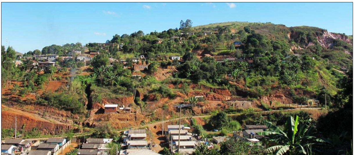
Figura 51. (a) Conjunto de Pontos de alto Risco bairro Córrego São Miguel (2,3,4,5,7,8,10,11,12,16), assentamentos precários, ausência de drenagem pluvial, processo erosivo em estágio avançado e cicatrizes de movimentos de massa.
