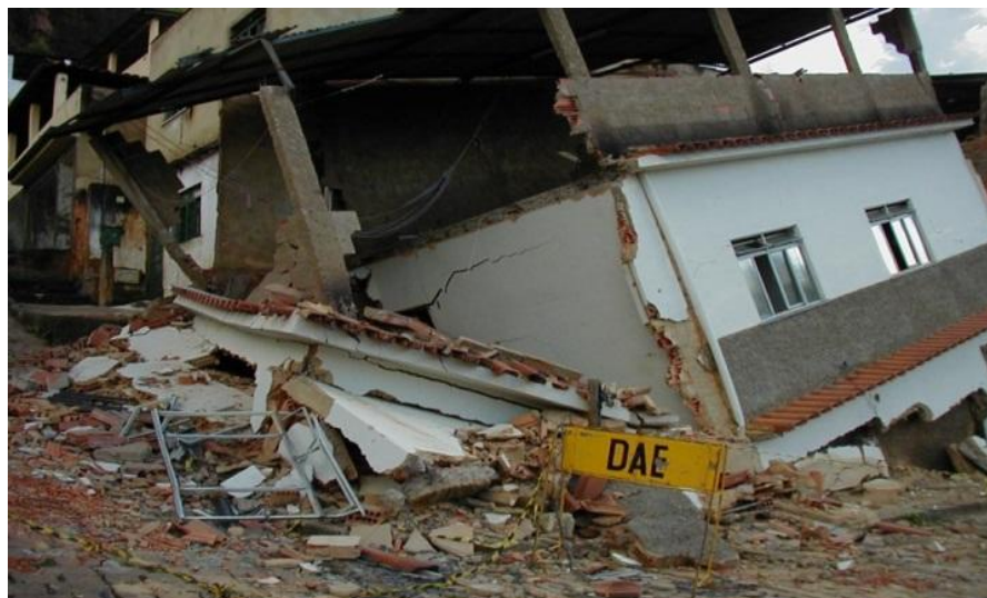
Figura 13 – Aspecto de casa do Bairro Panorama em 2005, após abalos e movimentação do solo.
