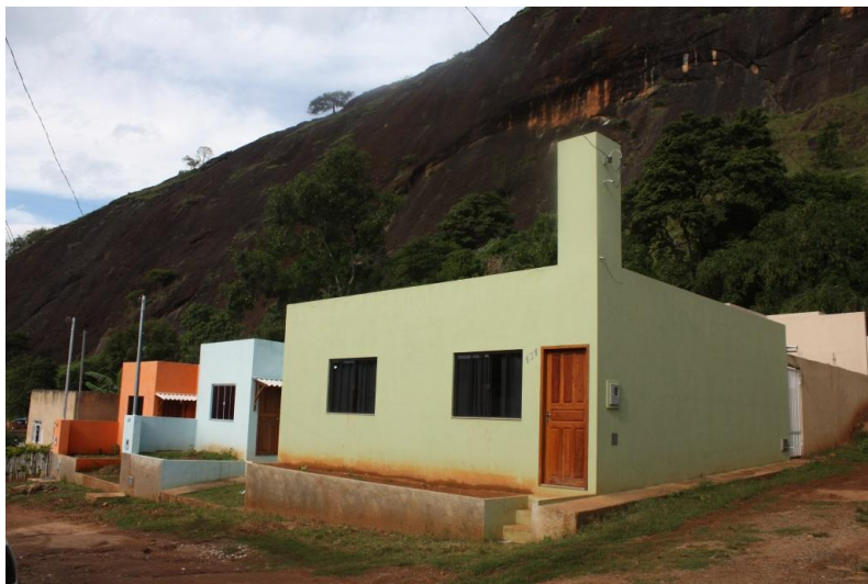
Figura 15 – Aspecto do conjunto de casas construídas em 2012 no Bairro Panorama – Carangola (MG) Fonte: Acervo pessoal da autora – Dezembro de 2012.
