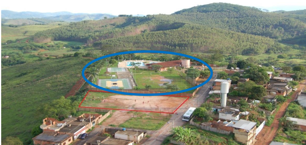
Figura 22 – Área do loteamento Campo de Aviação II, destinada a obras públicas - Carangola (MG) Fonte: Acervo Braz Cosenza, 2000, modificado pela pesquisadora.
